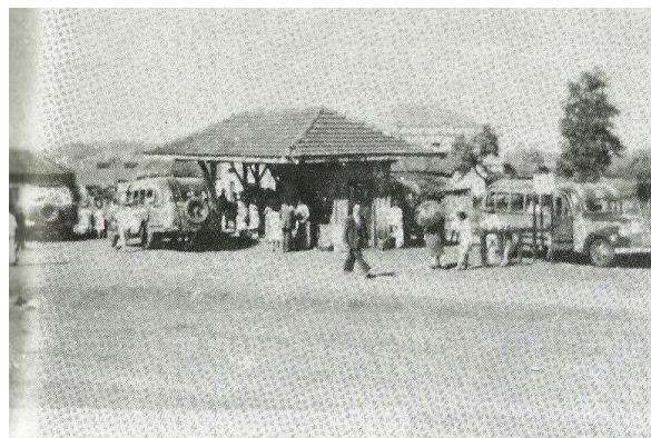
Figura 29: Terceira Estação Rodoviária de Londrina. Fonte CERNEV, 1995, p.7.
