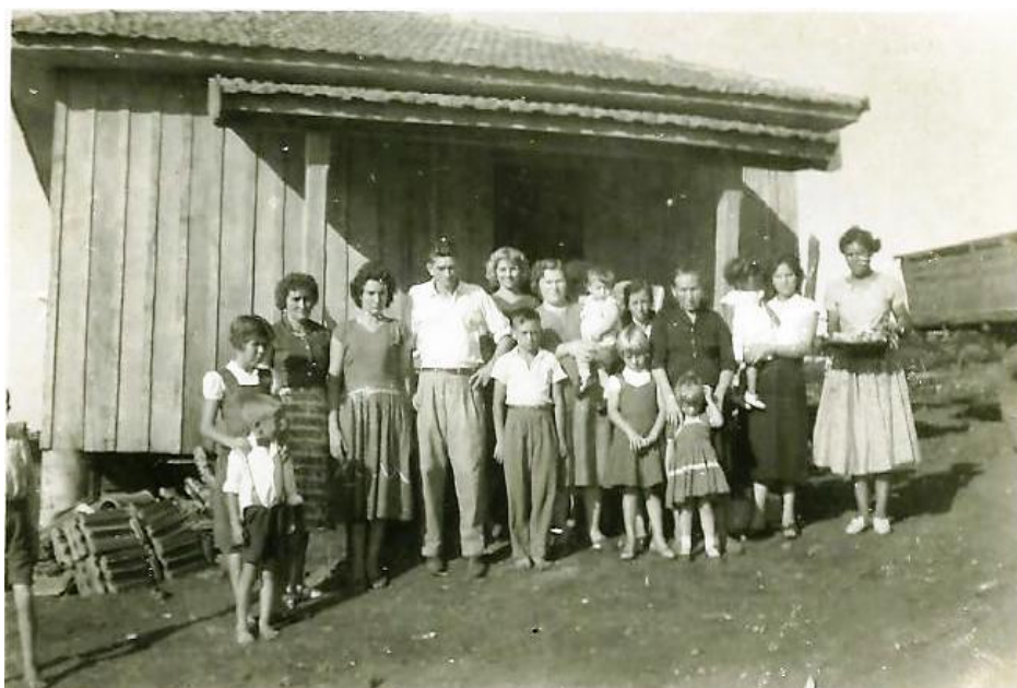
Figura 2: Braz e família em frente à primeira casa construída no lote 376, em São Tomé. Fonte: arquivos pessoais de Braz Ponce Martins.
