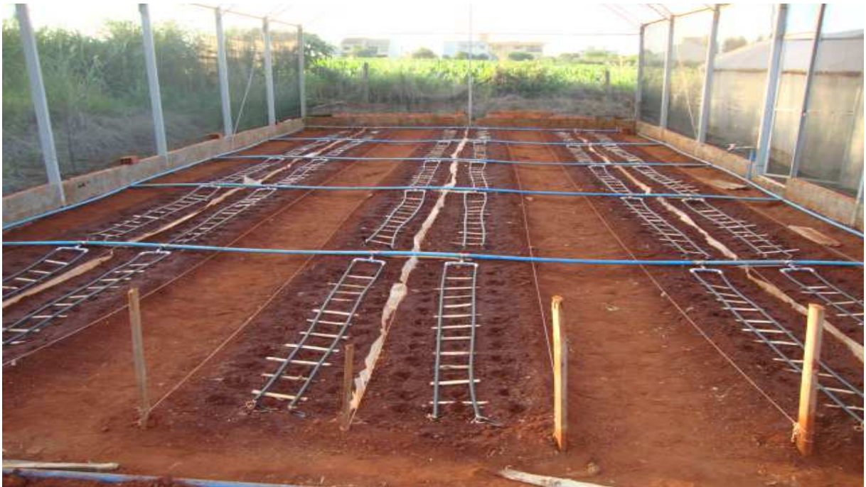
Figura 3. Ilustração do sistema de microirrigação por gotejamento instalado na área experimental antes de transplantar as mudas para o solo.
