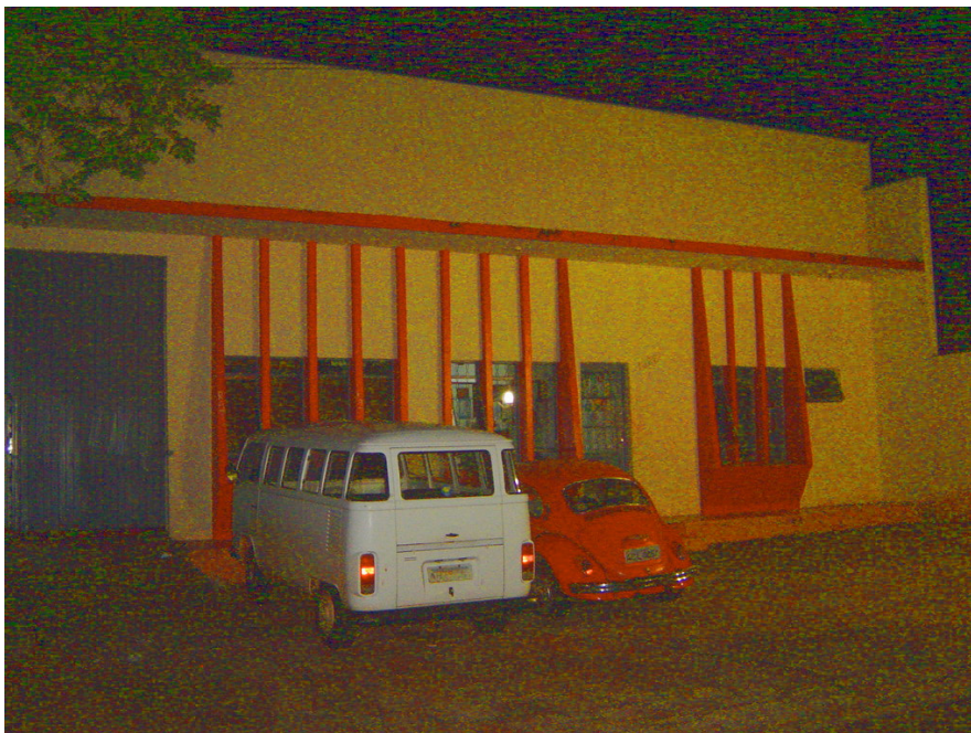
Foto 1 – Fachada do Abrigo Provisório Municipal
