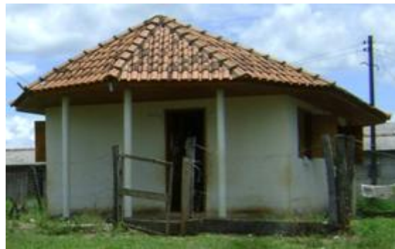
Figura 6 – Casa indígena construída a partir de 2003 pela Companhia de Habitação do Paraná (Cohab-PR).
