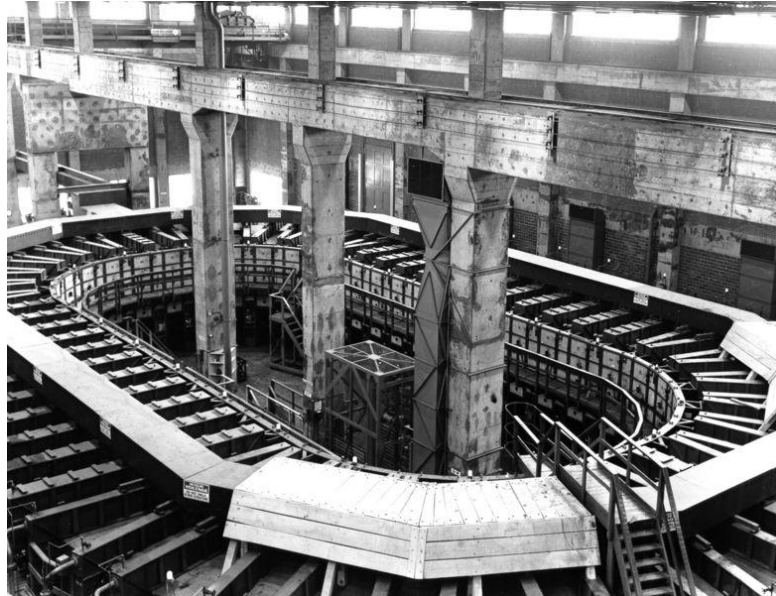
Figura 4: Instalação do Calutron gigante, desenvolvido pelo laboratório de Lawrence, utilizado no “ Site X ” durante a Segunda Guerra Mundial para enriquecer o urânio usado na primeira bomba atômica.
