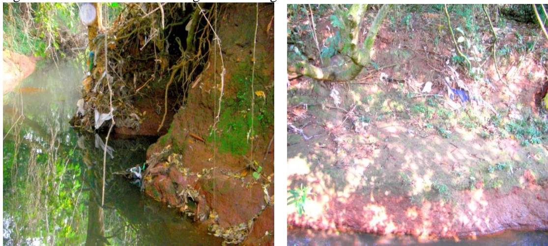
Figuras 52 e 53: Erosões nas margens do córrego Mandacaru
