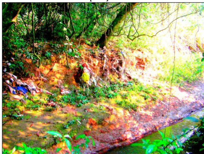
Figura 36: Margens desestabilizadas com deposição de resíduos sólidos e leito escavado
