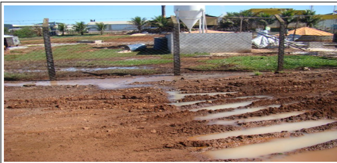
Foto 08 – efluentes líquidos sem tratamento, provenientes do processo de produção lançados a céu aberto pela empresa Docemelo, no Parque Industrial Sul. Fonte: SEMA/2009.
