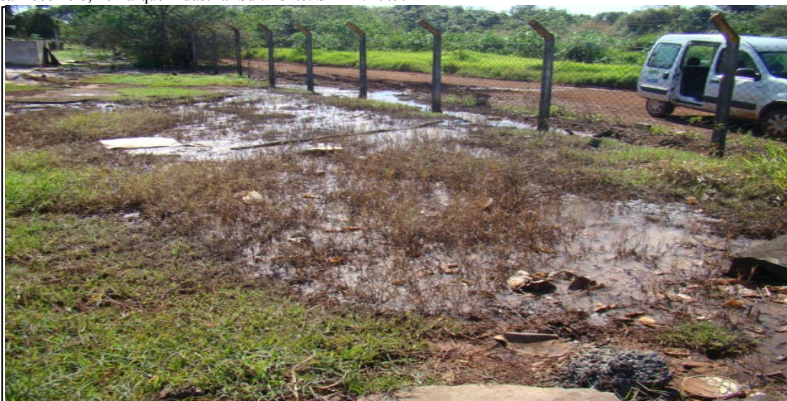
Foto 09 – efluentes líquidos sem tratamento, provenientes do processo de produção da empresa Docemelo, sendo carregados ao Parque das Perobas - Unidade de Conservação Municipal. Fonte: SEMA/2009.
