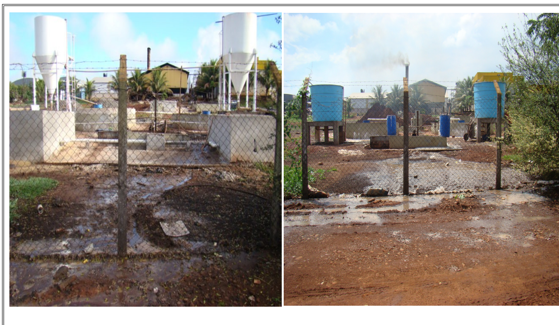
Fotos 51 e 52– Vista da empresa DOCEMELO aos fundos. Transbordamento de efluentes líquidos do processo de tratamento. Fonte: KERKHOFF, J. A., 2009.
