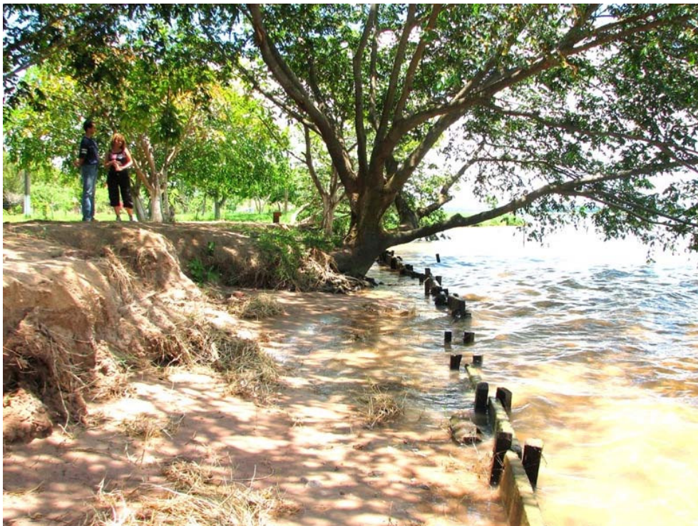
Figura 24 – Conforme observado, com o processo erosivo de remoção do solo instalado na margem do reservatório, a vegetação certamente fica condenada devido os movimentos das águas. Terra Rica – PR (Toniolo, 2005).
