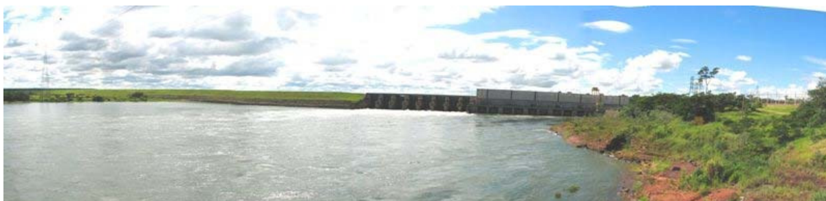
Figura 16 - Vista da barragem da UHE de Rosana entre os Estados do Paraná e São Paulo. A barragem apresenta uma extensão de 2.716,1 metros, o comprimento do reservatório é de 116 km, ocupando uma área de 220 km 2 . Diamante do Norte – PR (Toniolo, 2005).
