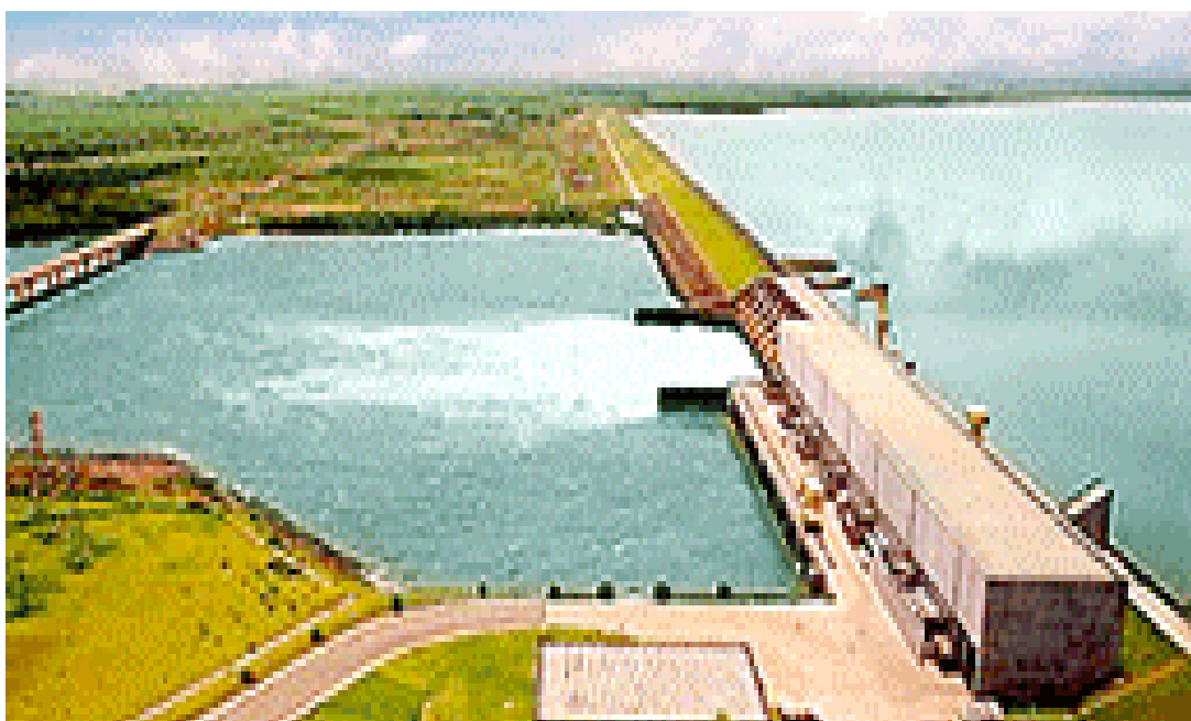
Figura 5 – vista da barragem da UHE de Rosana.
