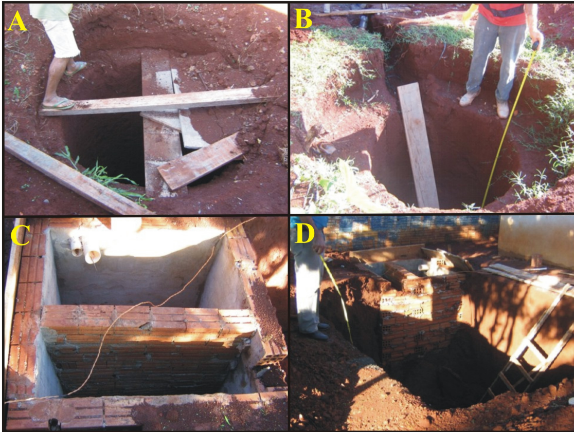
Figura 9. Fotografias com os tipos de fossas predominantes na cidade: A) fossa negra; B) fossa negra demonstrando entrada da tubulação e a base construída para construção do colarinho; C) caixa séptica; D) caixa séptica e sumidouro em área de solo raso
