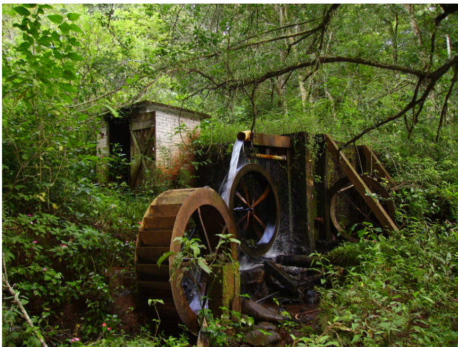
Foto 70 - Neste ponto, ocorre um grupo de nascentes na vertente direita do ribeirão onde se observa o uso intensivo da água com uma estrutura de rodas d'água, represa e casa de máquinas em que funcionava uma bomba, hoje abandonada em meio à vegetação. Não há resquícios de moradia, porém se levanta a hipótese de naquele local ter havido uma "colônia" - conjunto de casa na época da colonização que se beneficiava das nascentes.
