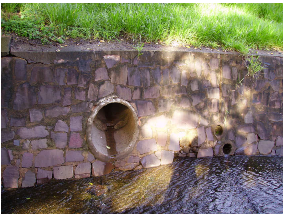
Foto 41 - Junto à calha concretada, durante toda a extensão do parque, se observam vários pontos de entrada de água, que, segundo Edson Denobi (SANEPAR) alguns são nascentes canalizadas; outros, galerias de águas pluviais.
