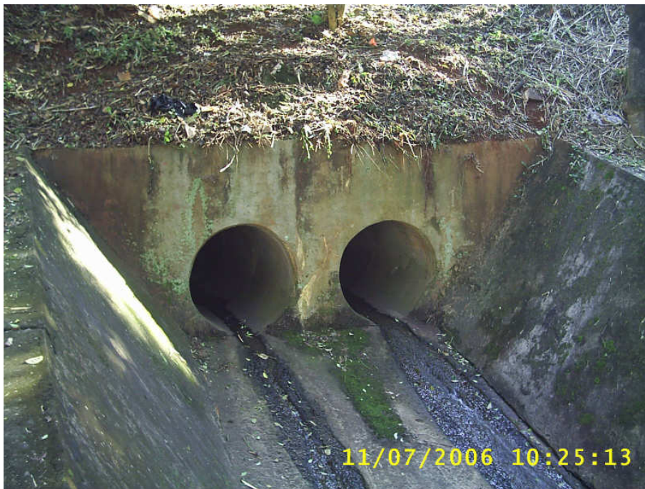
Foto 24 - Canalização da nascente do ribeirão Biguaçu. Na foto aparecem os primeiros sinais da água do ribeirão.
