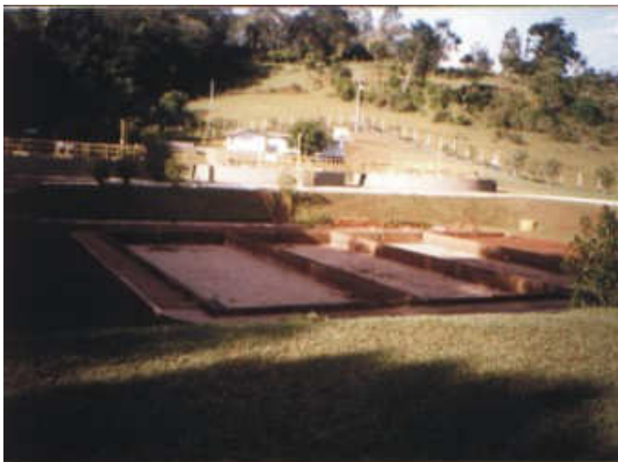
Foto 21 - ETE Biguaçu em 2005, localizada na zona de transição entre a área rural e urbana com destaque os RALFs, onde acontecia o tratamento anaeróbio. Autora: Faria (2005).
