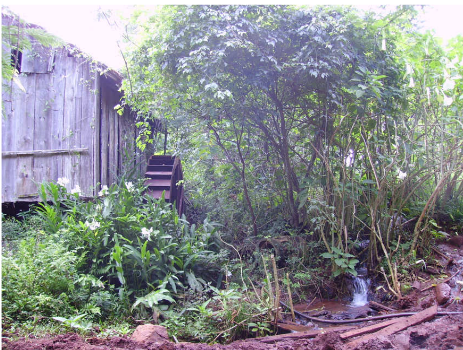
Foto 17 - Casa onde se encontra a máquina de beneficiamento de café com estrutura, quase que totalmente destruída. Se observa a casa e a roda que movia a máquina de café e a água do córrego (afluente do Biguaçu) que promovia esta situação. Autora: Faria (2007).
