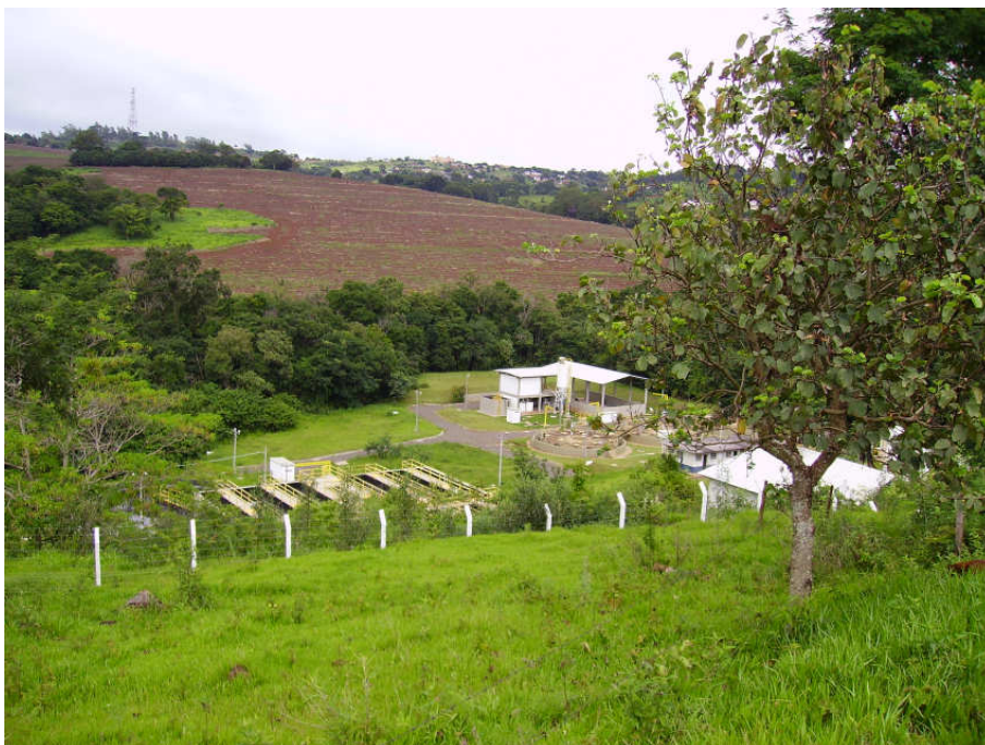
Foto 48 - À jusante do ribeirão Biguaçu, na vertente esquerda, tem-se a ETE Biguaçu, reestruturada em dezembro de 2006 para aumentar sua capacidade de tratamento. A porção de mata ciliar nessa área é mínima, com a presença de cultura mecanizada e uma parcela da área urbana. Autora: Faria (2006).
