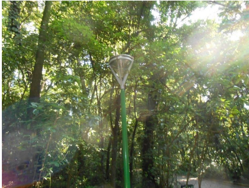
Figura 17 – Poste em coluna de ferro acimado por luminária tipo chapéu chinês.
