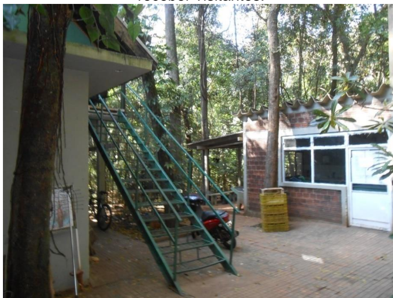
Figura 39 – Área da administração do parque. Escadas inadequadas para receber visitantes.
