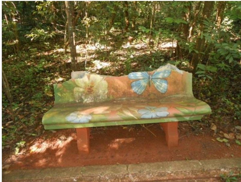
Figura 15 – Banco de concreto quebrado.
