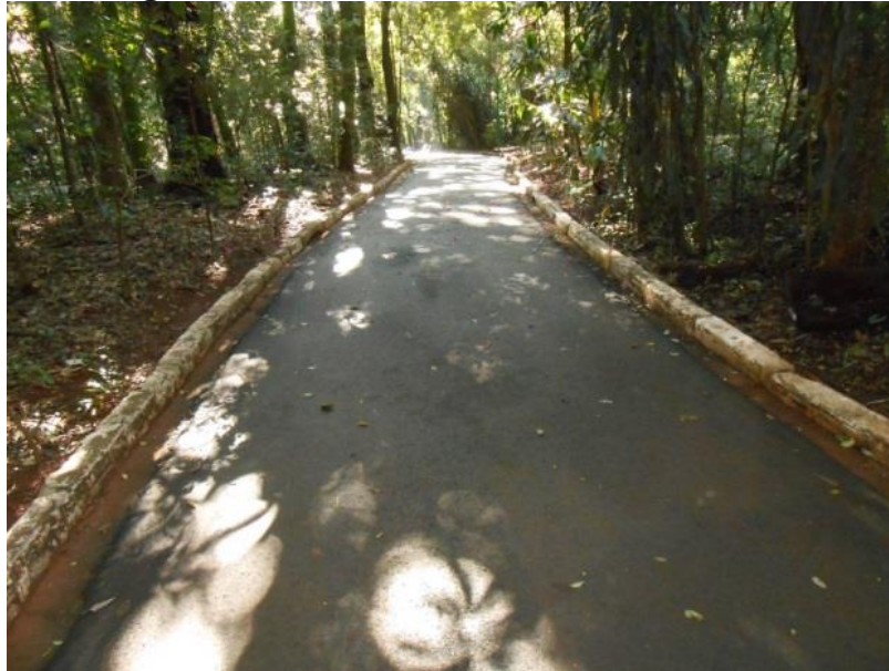
Figura 25 – Piso de asfalto na trilha central.
