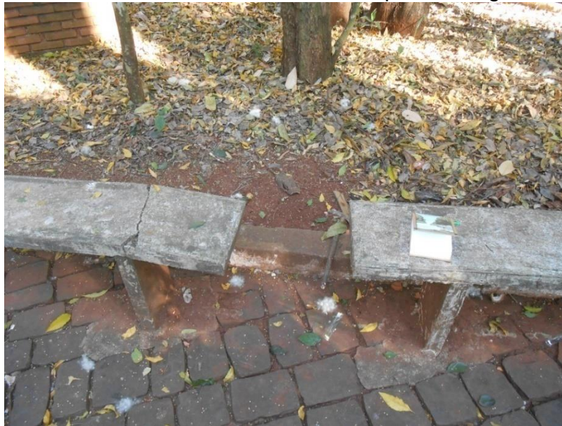
Figura 13 – Banco de concreto sem encosto e apoio, com grande rachadura.
