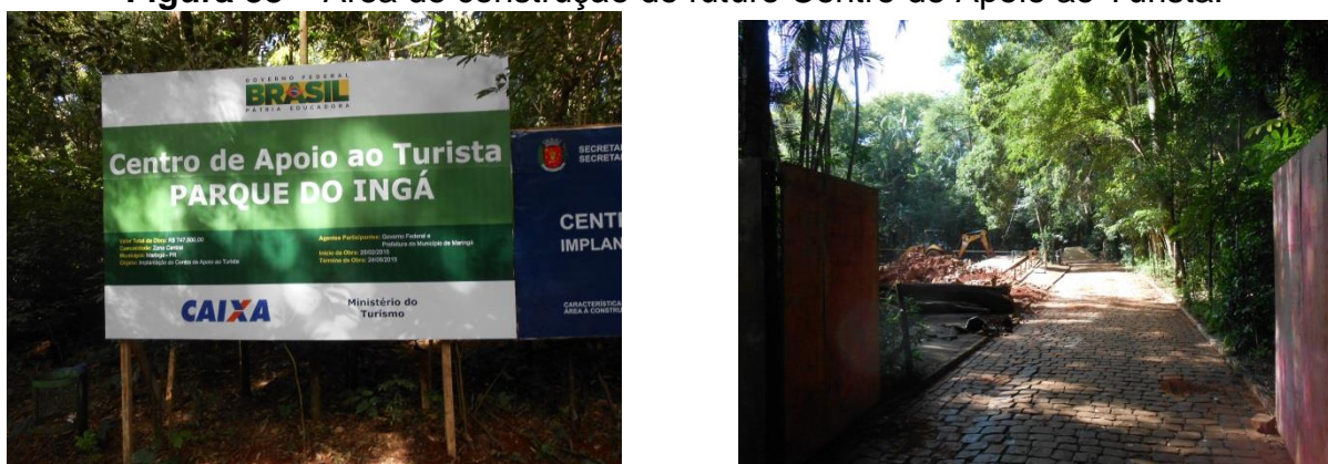
Figura 38 – Área de construção do futuro Centro de Apoio ao Turista.
