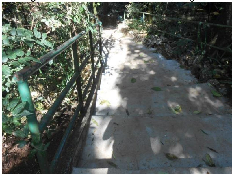
Figura 26 – Caminho com corrimão e degraus.
