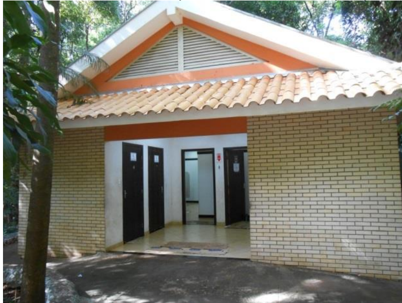
Figura 20 – Sanitário próximo à entrada do parque.
