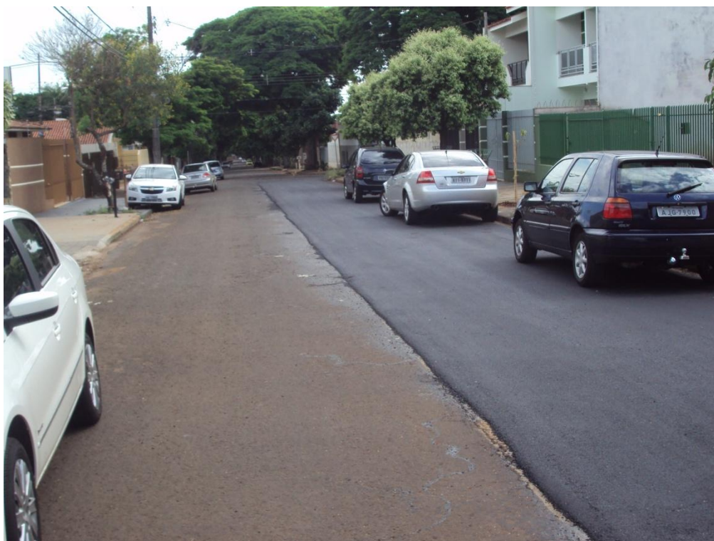
Foto 13 - Recapeamento sendo feito no Jardim Alvorada, próximo a Avenida Alexandre Rasgulaeff. FONTE: Arquivo Pessoal
