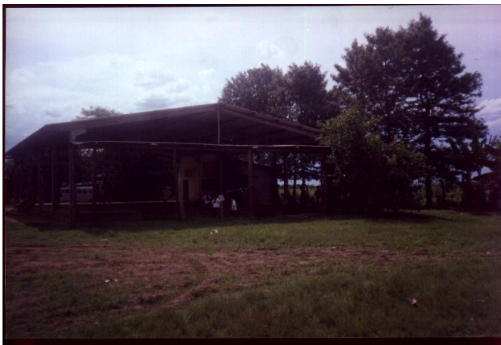
Figura 09: Barracão situado no pátio das escolas. 19 Fonte: Trabalho de Campo, (2005).
