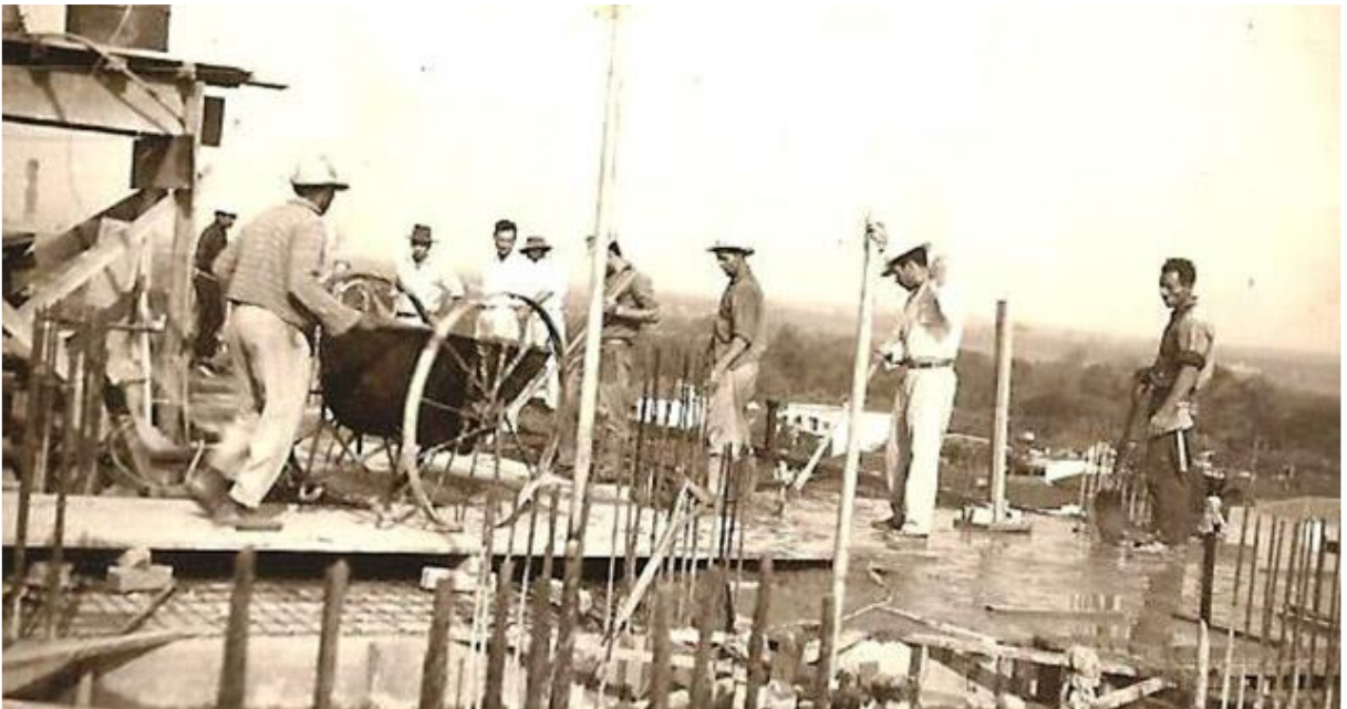
Figura 3 - Construção do Edifício Três Marias na área central de Maringá, década 1960.
