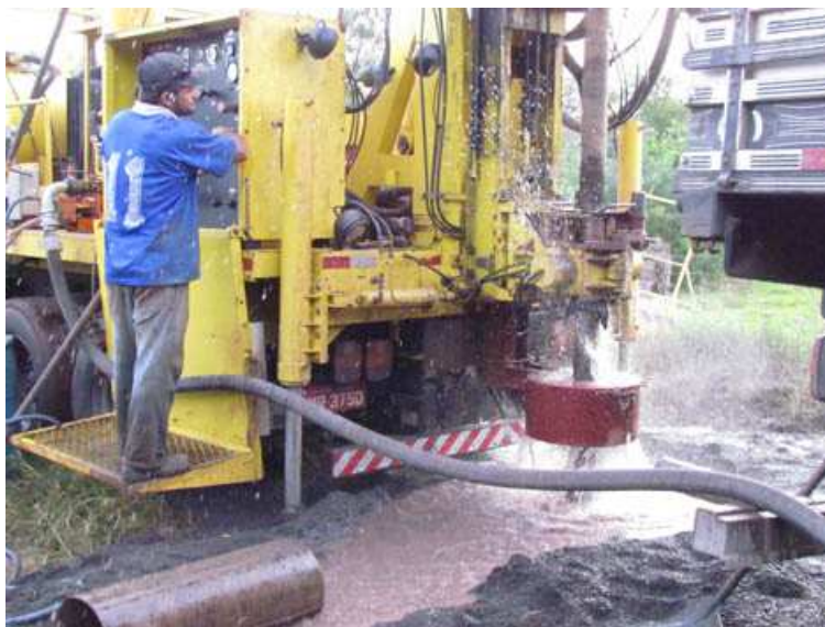
Figura 22 – Abertura de Poço Artesiano: Linha Vera Cruz. Fonte: Município de Santa Helena. Assessoria de imprensa (2012).
