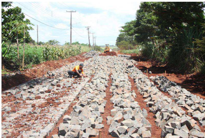
Figura 20 – Pavimentação poliédrica na área rural.
