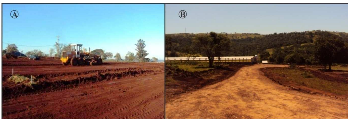
Figura 23 – A) Terraplanagem para a construção da Escola Municipal Presidente Kennedy; B) Conservação de estradas com acesso para aviários.
