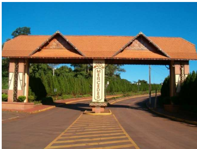
Figura 18 – Construção do portal de entrada. Fonte: Damião Xavier (2012).
