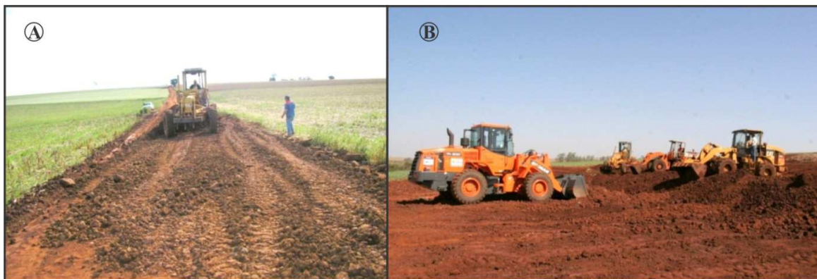
Figura 14 – A) Cascalhamento da estrada R5; B) Readequação da Estrada Marfim. Fonte: Município Terra Roxa. Assessoria de Imprensa (2012).
