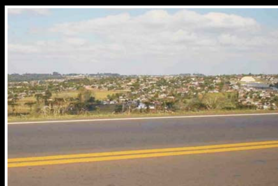
2 BR-369, saída para a cidade de Londrina. Colinas médias que fazem parte do Compartimento 1. Local de crescente expansão horizontal através de bairros residenciais
