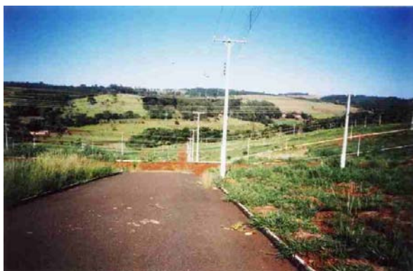
Loteamento "Residencial Interlagos" situado na passagem do C1 para o C5. Fortes declividades nos sopés onde o arruamento encontra-se perpendicular ao nível de base local, ocasionando sérios problemas de transporte de material e assoreamento das áreas rebaixadas.
