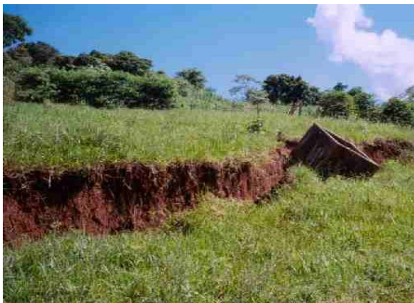
Area do Compartimento 6, onde no dia 20 de janeiro, após chuva intensa, o terreno cedeu de forma perpendicular deslocando-se de 0,50 a 2,20 metros para baixo.
