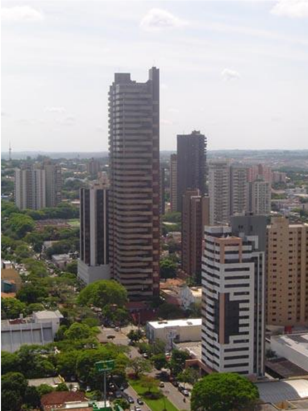
FIGURA 16: EDIFÍCIO ROYAL GARDEN, O MAIS ALTO DA CIDADE, COM 42 PAVIMENTOS
