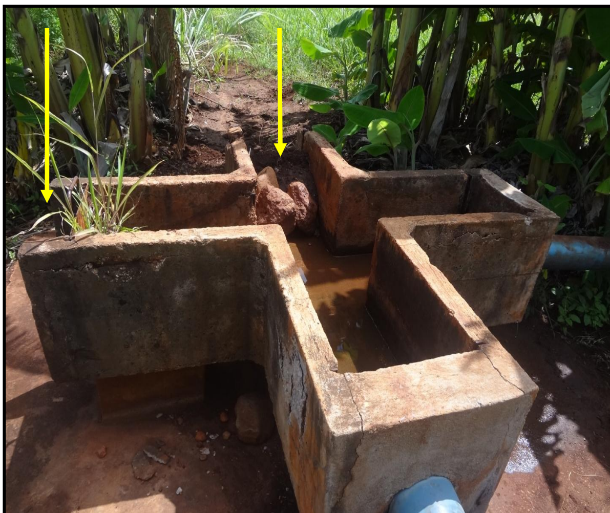
Figure 5: Hidrante de distribuição de água da irrigação de massaca, deprecado.
