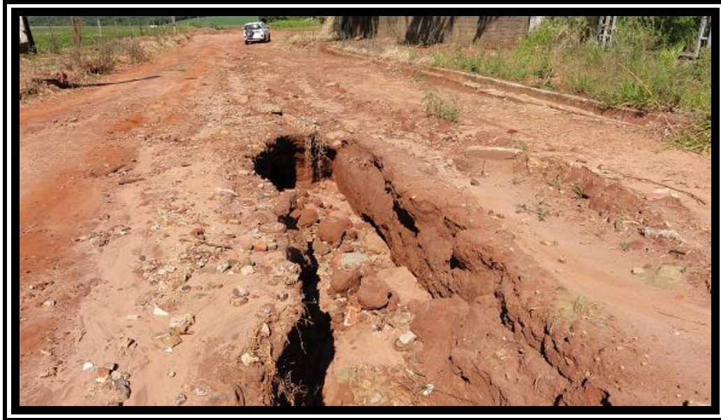
Figura 15 – Erosões provocadas por arruamento inacabado da área periurbana de Astorga – PR.
