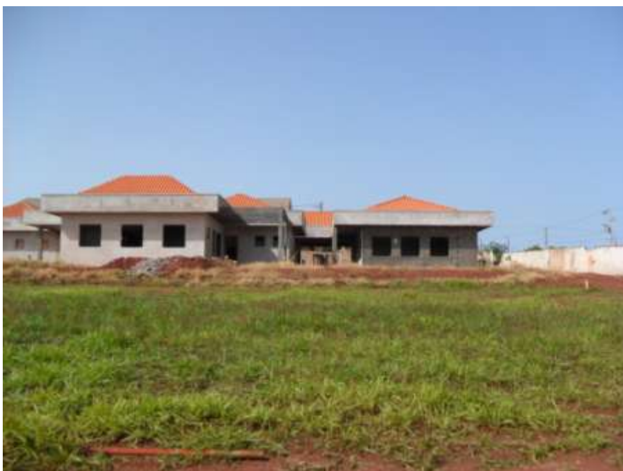
Figura 25. Florestópolis (PR). Construção da unidade escolar de ensino infantil Fonte: Fernandes, P. H. C. – 2011
