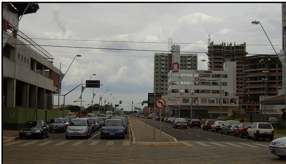
Foto 6 - Aspecto do Novo Centro que demonstra vários estágios das construções, com algumas já prontas, outras em andamento e outras sendo iniciadas.
