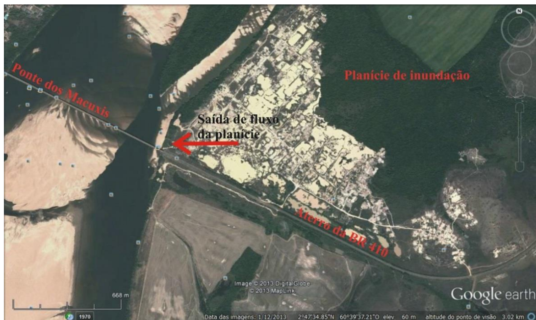
Figura 5.50: Aterro que atua no represamento da planície de inundação localizada junto à margem esquerda do rio Branco, nas proximidades da cidade de Boa Vista (localizada junto a margem direita do rio Branco). Neste local o fluxo de cheias da planície de inundação é jogado de volta ao canal na cabeceira da ponte dos Macuxis. Pode ser observado ainda uma fonte potencial de sedimento em suspensão devido as atividades de oleiros no local (Fonte: GeoEye, 2014)
