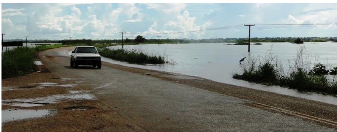
Figura 5.44: Represamento do fluxo do rio Branco em sua margem esquerda pelo aterro da Rodovia BR 401, sentido Bonfim – Boa Vista (Foto: Fábio L. Wankler, junho de 2011)
