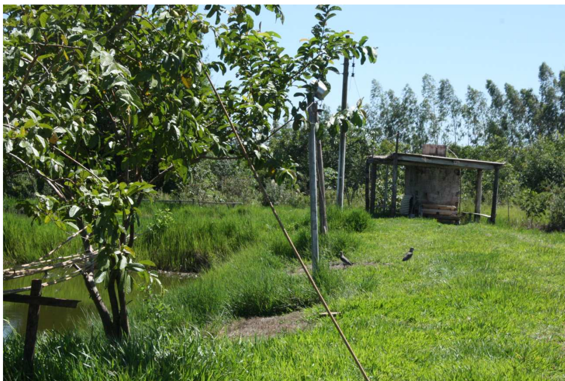
Figura 45- Estrutura precária – ao fundo – utilizada para o bombeamento de água (insalubre) subsuperficial. Município de Terra Rica. Fonte: TONIOL, F.P.F. (2015)
