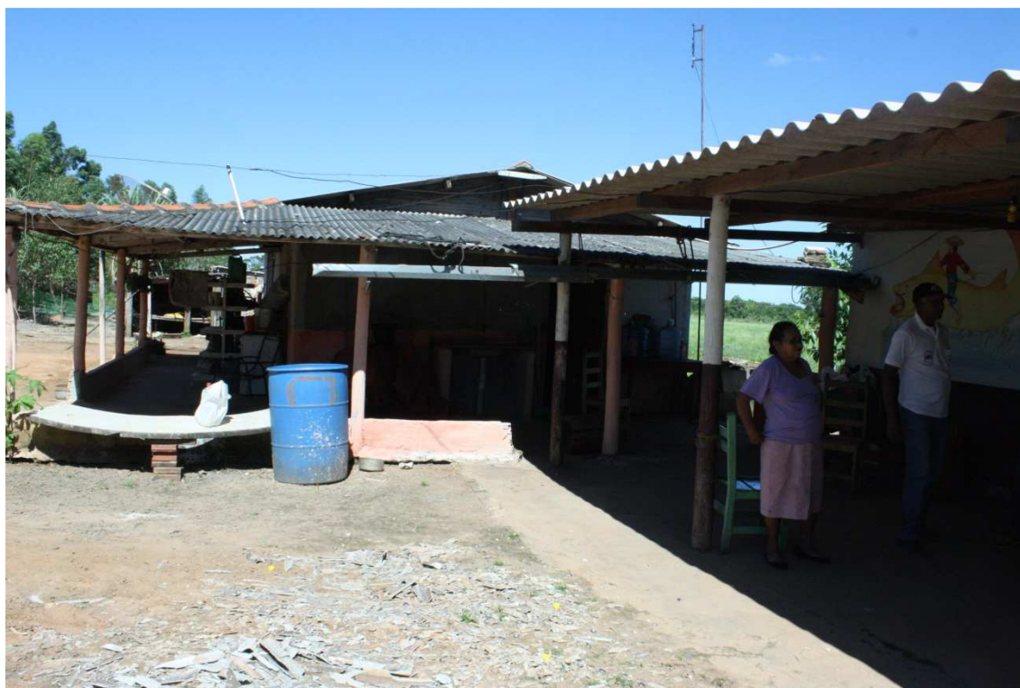
Figura 44- Estrutura de moradia de pequenos produtores mutuários do Programa Banco da Terra. Município de Terra Rica. Fonte: TONIOL, F.P.F. (2015)
