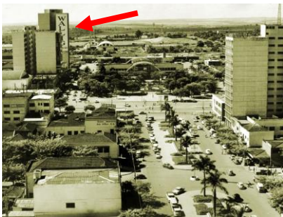
Figura 22. Vista de empena no edifício Herman Lundgren, década de 1970.
