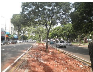
Figura 114. Vista do canteiro central sem a presença do concreto do estacionamento da Av. Brasil Ricardo M. Albertin, 12/01/2014.
