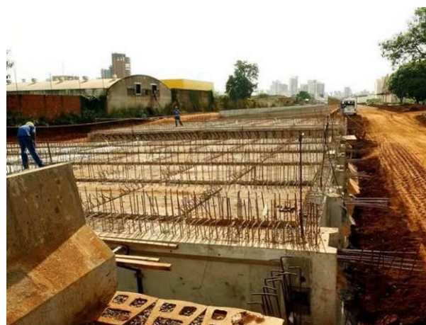
Figura 82. Vista das obras do viaduto da Av. Tuiuti (2007). Fonte: SKYSCRAPERCITY (2008).
