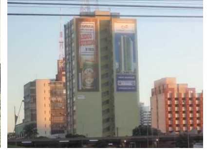
Figura 21. Vista de empena no edifício Herman Lundgren, ano de 2015.
