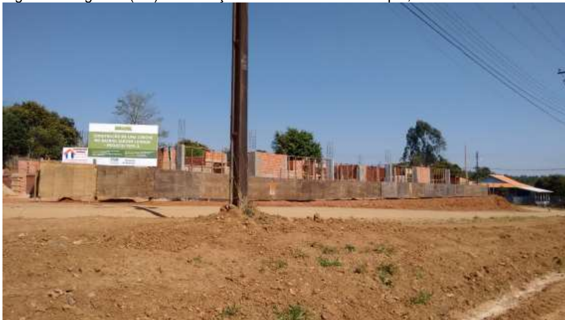
Figura 52. Figueira (PR). Construção de uma creche municipal, 2016
