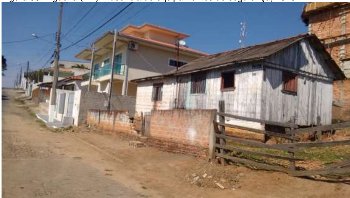
Figura 58. Figueira (PR). Ausência de equipamentos de segurança, 2016
