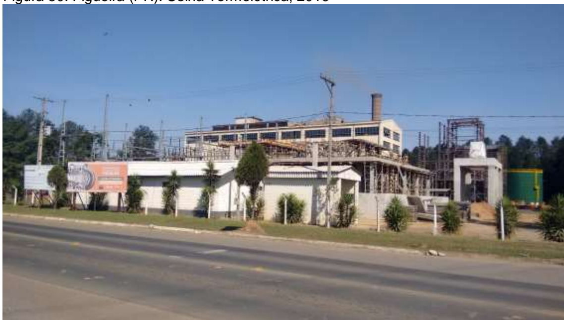
Figura 50. Figueira (PR). Usina Termelétrica, 2016
