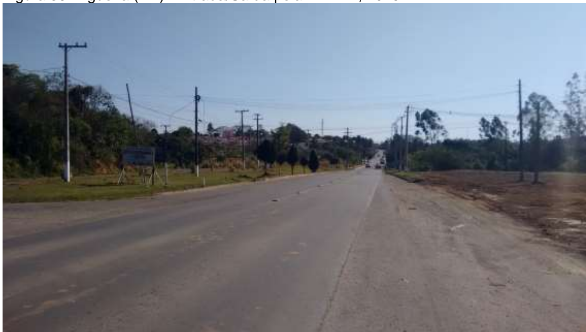
Figura 39. Figueira (PR). Entrada/Saída pela BR-272, 2016
