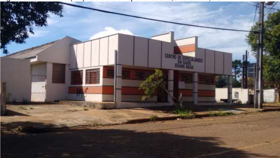
Figura 80. Tamarana (PR). Centro de Especialidades, interditado, 2017
