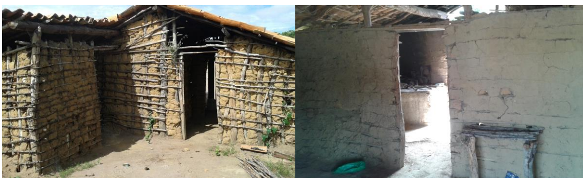
Figura 38: Moradia na Serra Barreiro Novo. Foto: Ribeiro, Vitor Hugo, 2016.
