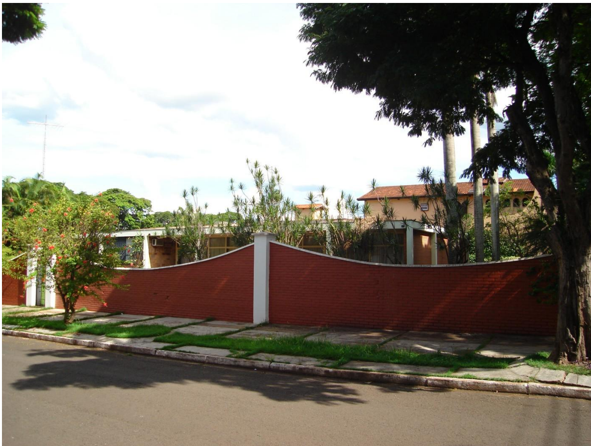
Figura 13 – Fachada e muro da Residência da Rua Tomé de Souza, nº 261
