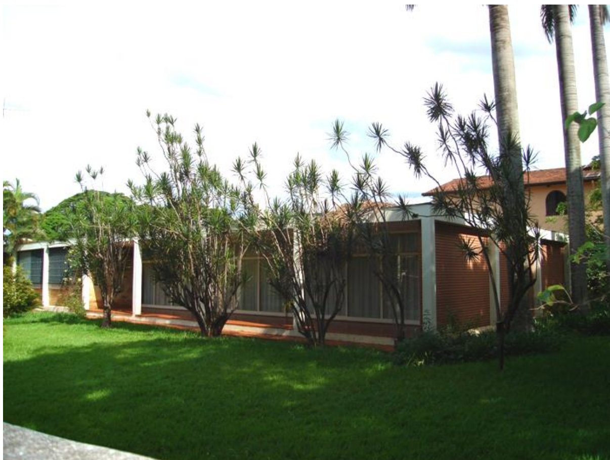
Figura 14 – Fachada da Residência na Rua Tomé de Souza, nº 261
