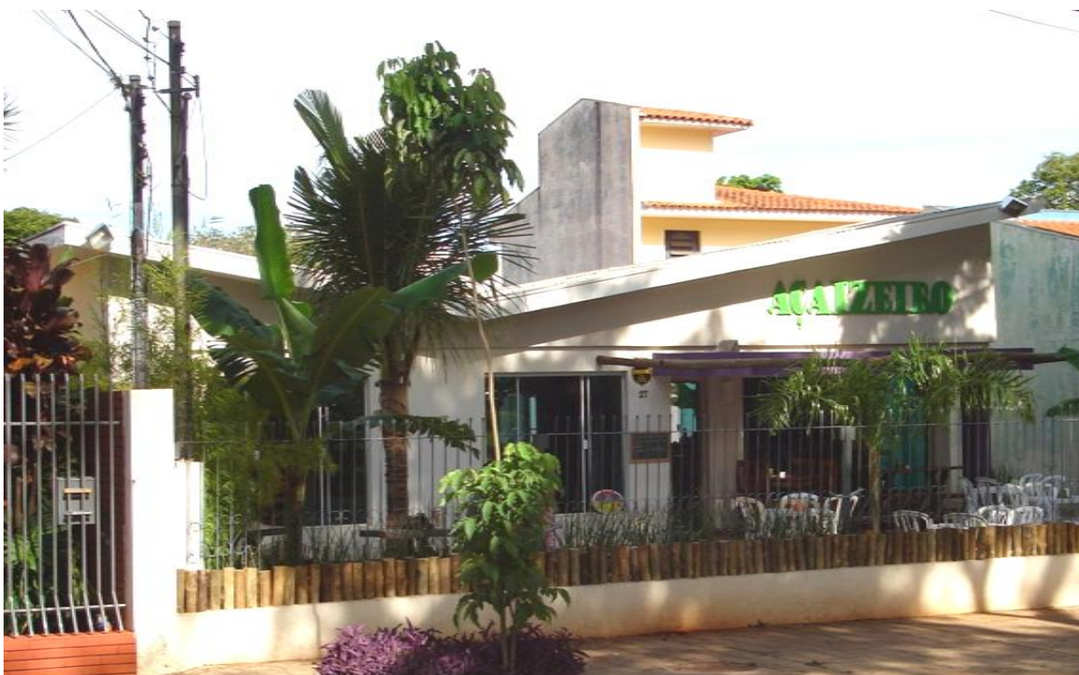
Figura 8 – Fachada da Residência Rua Tomé de Souza nº 27 (outro ângulo)
