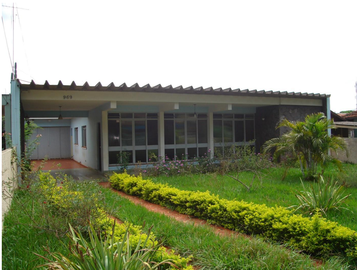
Figura 27 – Fachada da Residência na Rua Neo Alves Martins, nº 969.
