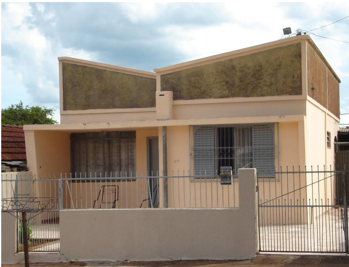
Figura 23 – Fachada da Residência na Travessa Barroso.
