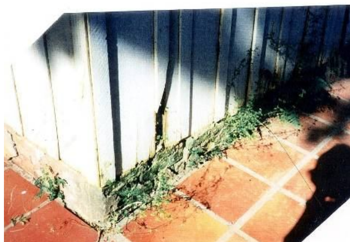
Imagem 12. Área externa da Capela Nossa Senhora Aparecida. Ano 1999. Acervo SPHAM
