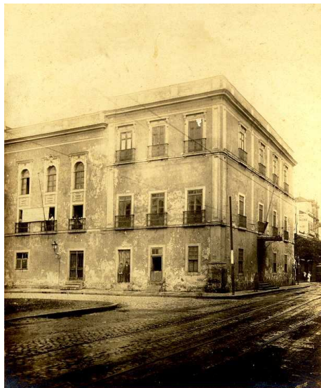
Figura 3 Vista exterior da Câmara
