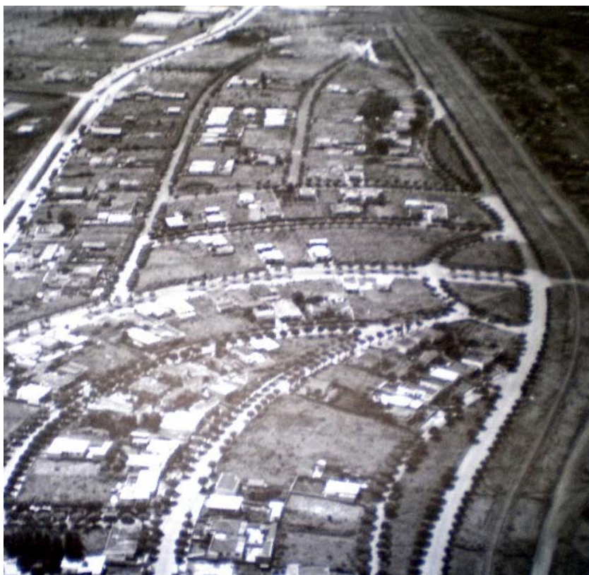
Vista parcial do Loteamento Shangri-lá A. À direita a linha do trem parte do loteamento ‘Jardim do Sol’. Década de 1950. Acervo: Museu Histórico Pe Carlos Weiss.
