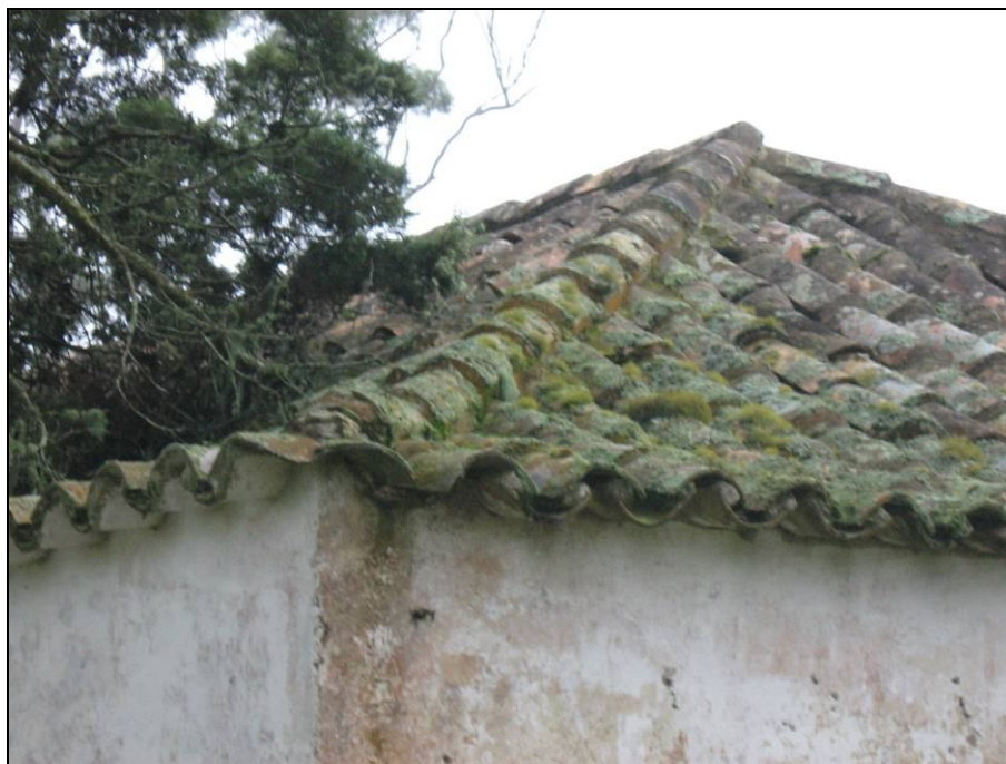
Figura 18. Detalhe do telhado em “quatro águas” Fazenda Liscano II (VCP) - Arroio Grande 2592x1944 pixels - Em 09/07/2008 Arquivo: da autora
