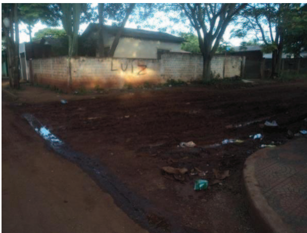
Imagem 03: Avenida Nova Londrina – Região sul da cidade Fonte: arquivo pessoal
