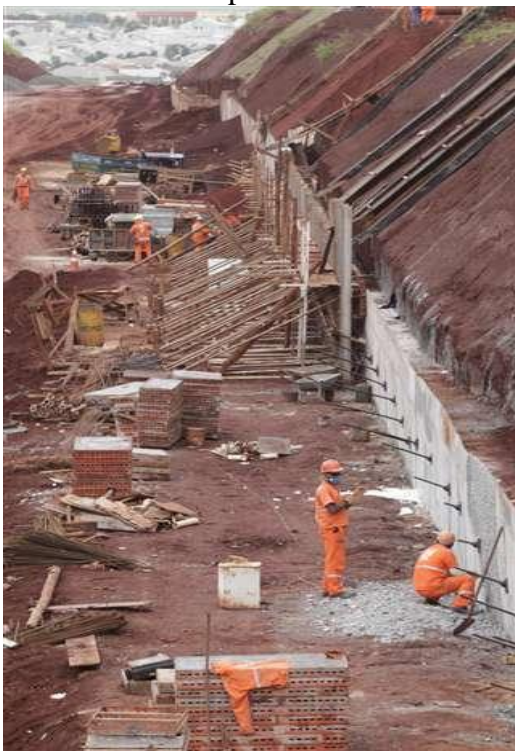
Trecho em obras do Contorno Norte
