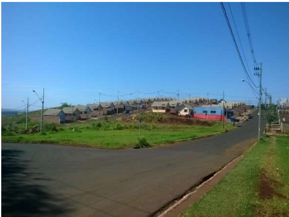
Figura 5 – Moradias do Conjunto Habitacional José Israel Factori em Floriano – Maringá - 2017
