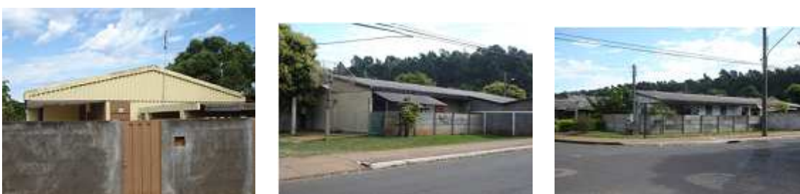
Figura 8 – Vista da fachada de casas de Nível N2 do núcleo habitacional Primavera (Padrão B) Fonte: Vianna (2006b)
