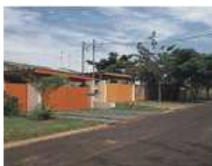
Figura 5 - Vista da fachada de uma casa de Nível N5 do núcleo habitacional Primavera Fonte: Vianna (2006b)
