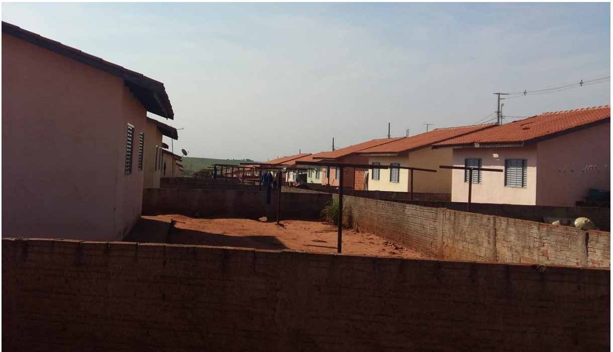
Figura 5 - Visão interna do alojamento
