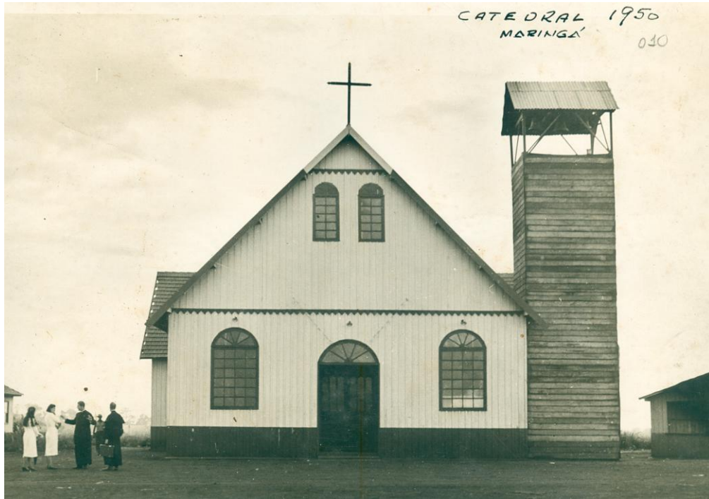
Figura 75 – Igreja de madeira, 1950.
