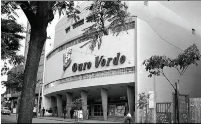
Figura 11- Cine Ouro Verde (1948-52), projetado por Vilanova Artigas e Carlos Cascaldi.
