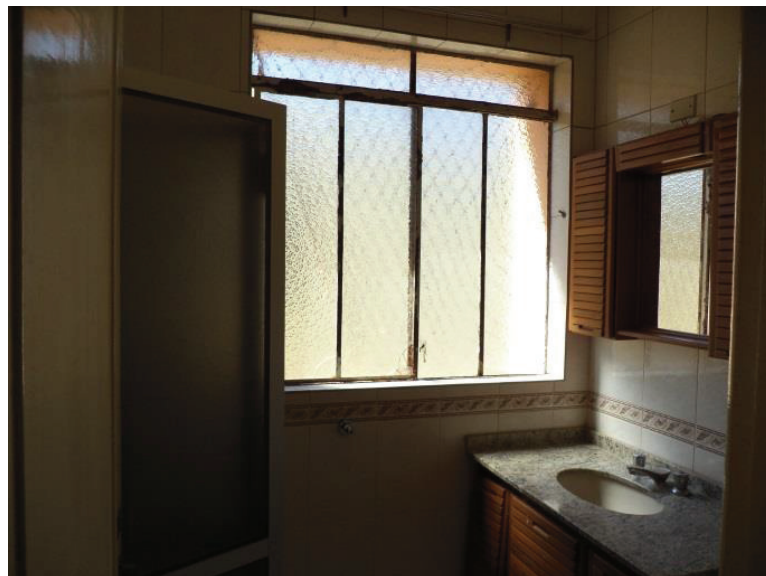
Figura 50- Esquadria do bwc. do apto. 201, Bloco C.
