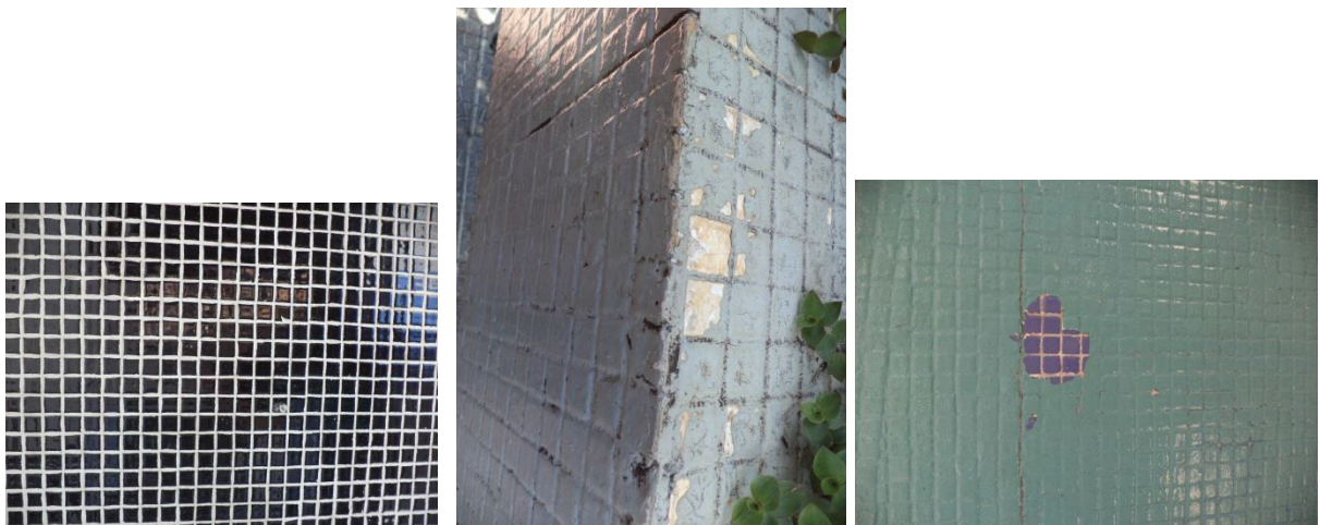
Figuras 42,43 e 44- Revestimentos em pastilhas cerâmicas dos pilares e paredes
