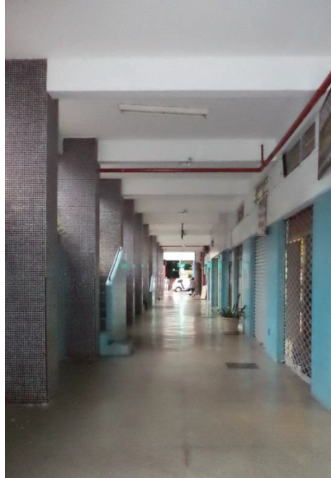
Figura 25 – Corredor de circulação do pavimento inferior da galeria com acesso à rua Piauí pelas escadas.
