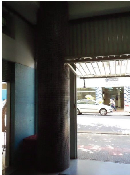
Figura 41- Pilar circular no acesso pela Rua Souza Naves
