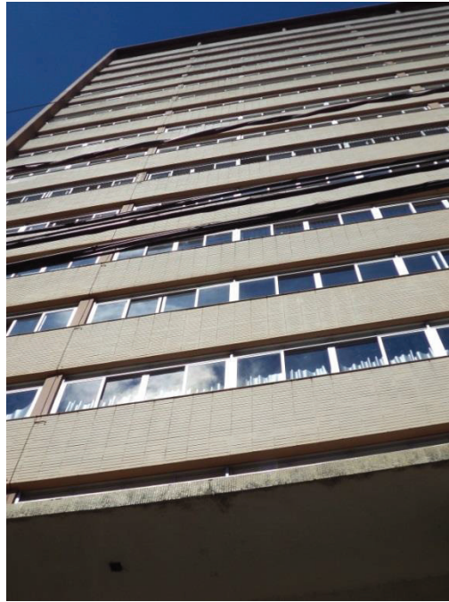
Figura 54- Fachada do Edifício Bosque
