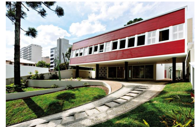
Figura 49 - Residência Romário Pacheco, Cornelsen, 1953, Curitiba. Fonte: Portal Top View. Disponível em: < http://topview.com.br/materia/uma-lolo-restaurada/#ad-image-0 > Acesso em: 12/Jan./2016.
