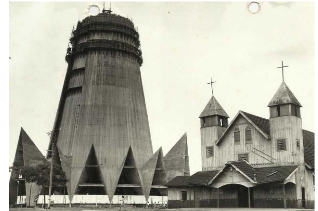
Figura 76 - Catedral de Maringá em construção. Fonte: acervo da Arquidiocese de Maringá.
