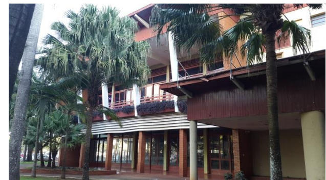
Figura 82 - Sacada do Grande Hotel Maringá. Fonte: Acervo da autora, julho de 2015.
