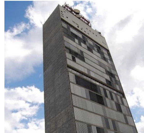
Figura 42 - Sede Telepar, Ficinski Dunin, 1966, Curitiba. Fonte: Portal Circulando por Curitiba. Disponível em: < http://www.circulandoporcuritiba.com.br/2009_09_01_archive.html > Acesso em: 08/jan./2016.
