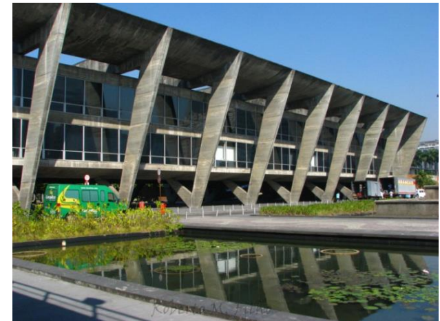
Figura 10 - Museu de Arte Moderna do Rio de Janeiro, Affonso Eduardo Reidy, 1953, Rio de Janeiro.
