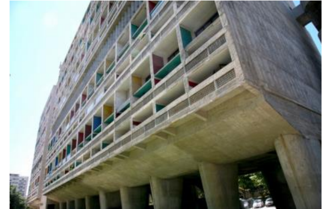
Figura 4 - Unité d'Habitation , Le Corbusier, 1945, Marselha. Fonte: ArchDaily. Disponível em: < http://ad009cdnb.archdaily.net/.../1288458615-unite-vincent-desjardins6.jpg >. Acesso em: 06/Out./2014.
