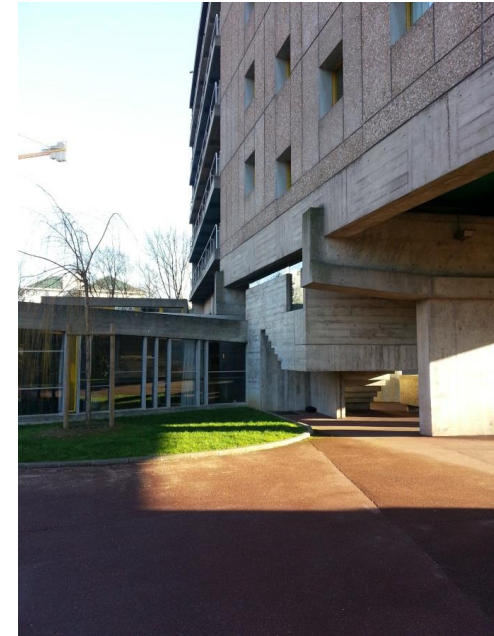
Figura 96 – Escada em concreto da Maison du Brésil . Fonte: acervo da autora, fev. 2013.
