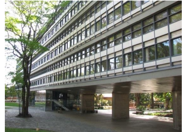
Figura 12 - Edifício E-1 EESC-USP, Queirós Duarte e Carvalho Mange, 1953, São Carlos.
