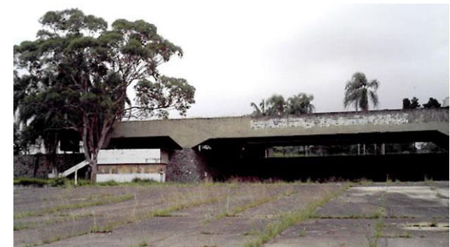
Figura 19 - Garagem de barcos do Clube Santa Paula, Cascaldi e Artigas, 1961, São Paulo. Fonte: Portal Arquitetura Brutalista. Disponível em < http://www.arquiteturabrutalista.com.br/.../1961-53-fichatecnica.htm >. Acesso em 10/jun./2015.
