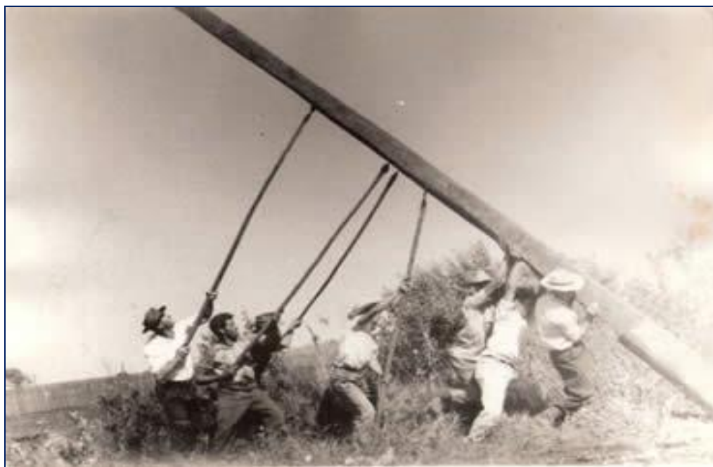
Figura 28: Instalação da rede elétrica em Campo Mourão década de 1950. Fonte: Acervo do Museu Deolindo Mendes Pereira, 2013.
