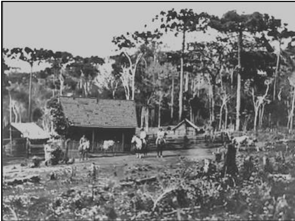
Figura 07: Casa de sapé de João Bento em Campo Mourão, na região do Parque Municipal, 1905. Fonte: Acervo do Museu Deolindo Mendes Pereira, 2012.
