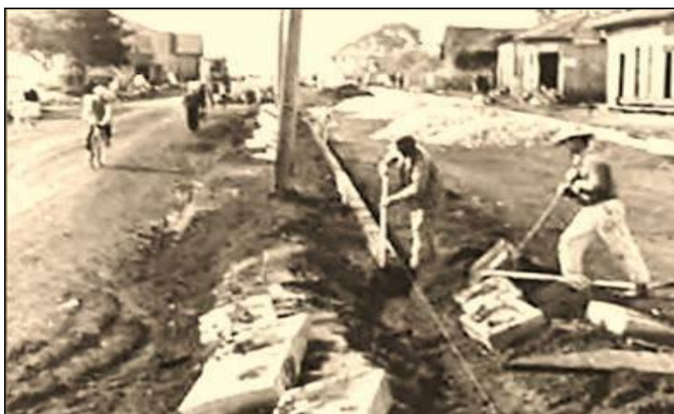
Figura 36: Início da implantação asfáltica na Av. Capitão Índio Bandeira, 1960. Fonte: Wibaju, 2012.
