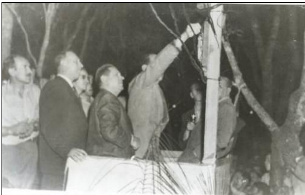
Figura 27: Solenidade com a ligação da energia elétrica com a presença do governador Moysés Lupion Campo Mourão década de 1950.
