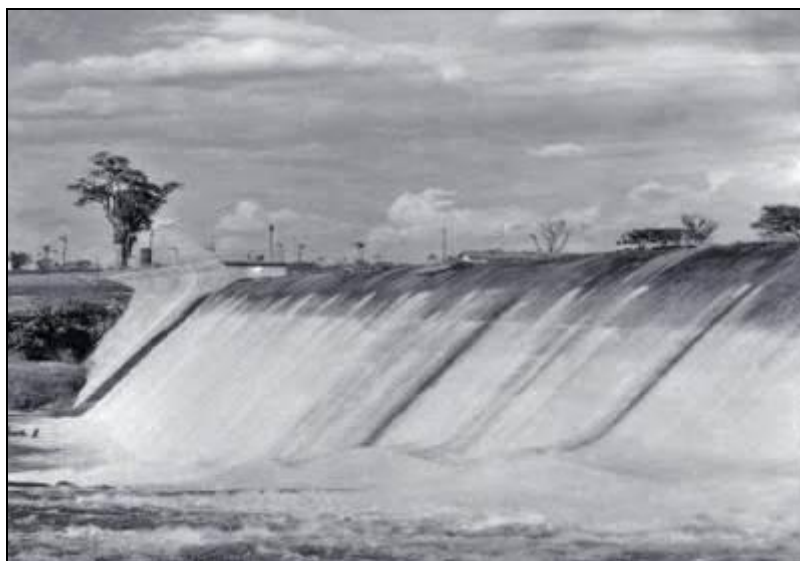
Figura 33: Usina Hidrelétrica Mourão, já ampliada e em funcionamento, 1964. Fonte: Wille Bathke Jr, 2012.
