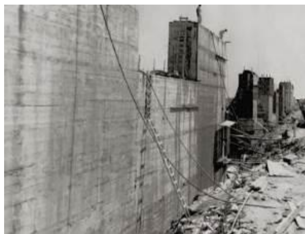
Figura 32: Fase de ampliação da Usina Hidrelétrica Mourão I, no rio Mourão, 1958. Fonte: Wille Bathke Jr, 2012.
