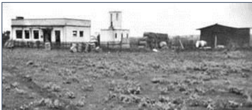
Figura 29: Estação Aeroviária Cel. Geraldo Ghia de Aquino (1953). Fonte: Wille Bathke Jr, 2012.
