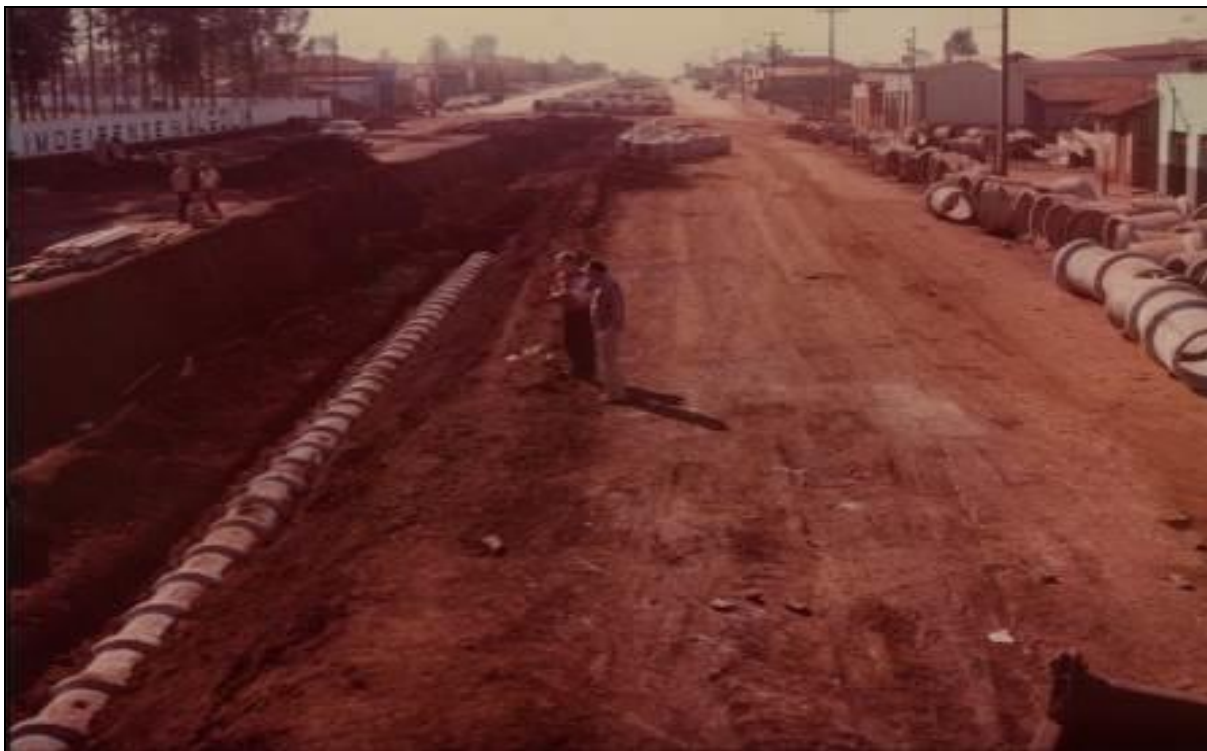
Figura 46: Avenida John Kennedy, em 1964, recebendo instalações de rede de esgoto e asfalto. Nesse mesmo ano o vereador Augustinho Vecchi apresentou projeto de lei mudando a denominação da Avenida Federal para Avenida Presidente John Kennedy. Fonte: SANTOS JR., J. E. (2013).
