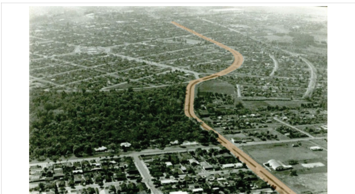
FIGURA 18: TRECHO DA PERIMETRAL SUL, EM 1980, DESTACANDO AS AVENIDAS JUSCELINO KUBITSCHECK E LAGUNA
