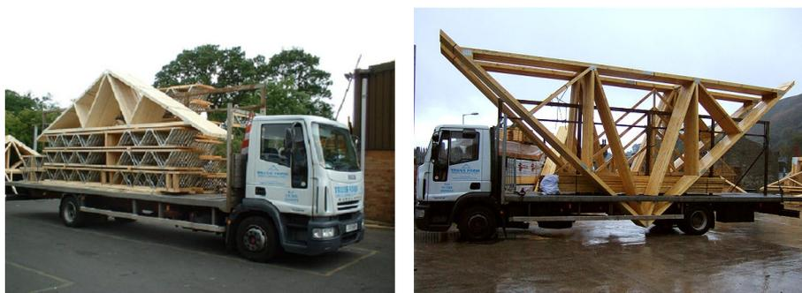
**Figura 9 Transporte de Caibros treliçados pré-fabricados.**
