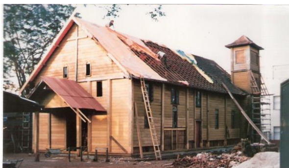
Figura 87 – Estrutura da cobertura sendo coberta por lonas
