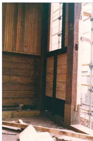
Figura 89 – Detalhe revestimento externo, “alma” e revestimento interno.
