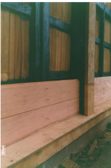
Figura 89 – Detalhe revestimento externo, “alma” e revestimento interno.
