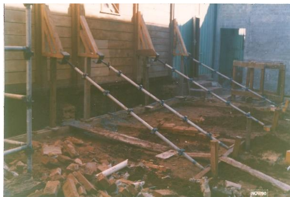
Figura 85 – Fotografia Capela Santa Cruz suspensa por macacos hidráulicos
