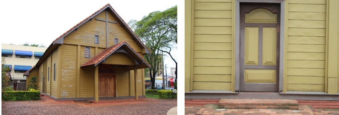
Figura 95 - Fotografia externa Capela Santa Cruz Figura 96 - Fotografia entrada lateral Capela Santa Cruz
