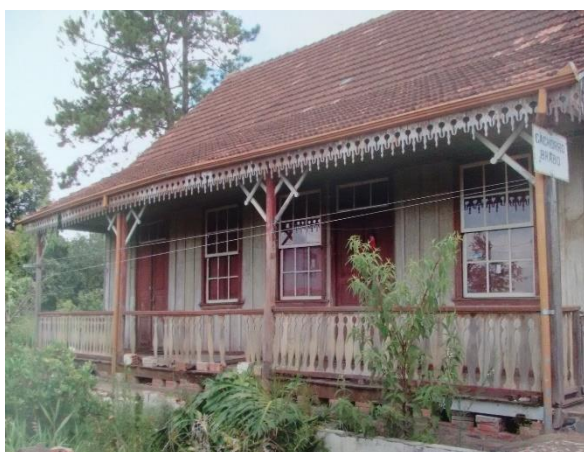
Figura 4 – Fotografia da Casa Dembinski na cidade de Irati
