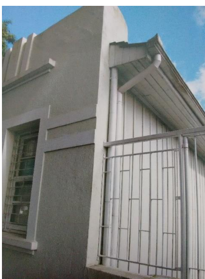
Figura 8 –Fotografia da de casa de madeira com fachada de alvenaria.
