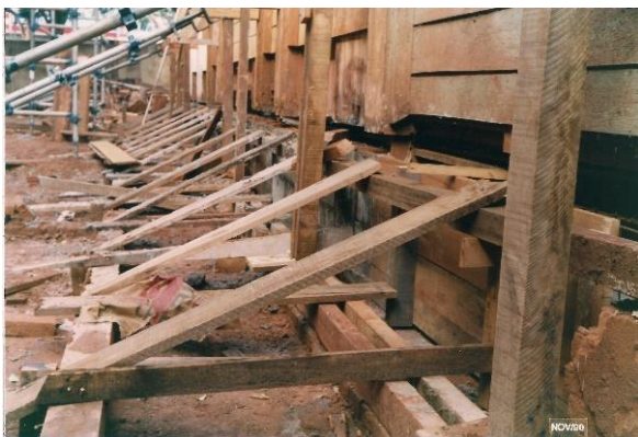
Figura 85 – Fotografia Capela Santa Cruz suspensa por macacos hidráulicos
