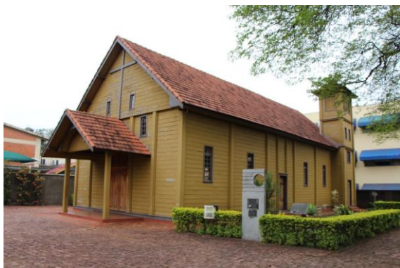
Figura 52 – Fotografia externa Capela Santa Cruz
