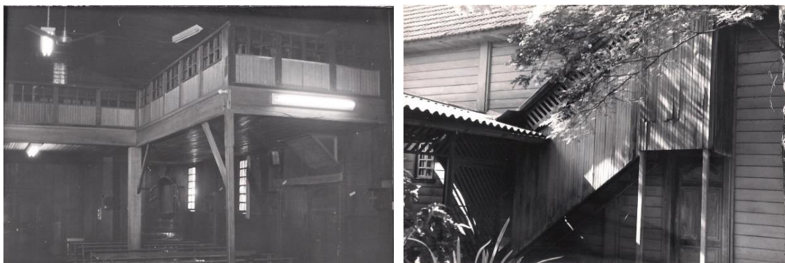
Figura 91 – Coro retirado na restauração Figura 92 – Escada retirada na restauração
