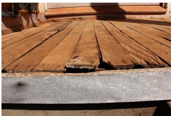
Figura 103 – Fotografia desgaste piso Capela São Bonifácio
