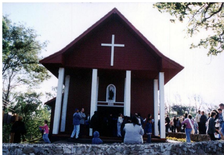
Figura 36 – Fotografia da Capela São Bonifácio após reforma
