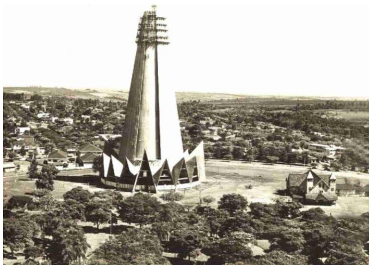
Figura 28 – Fotografia construção da Catedral N. S. da Glória em concreto em 1972
