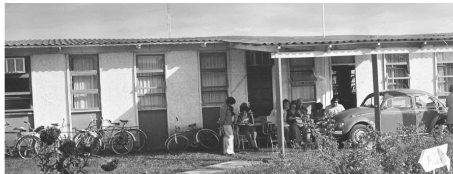
Figura 42 - Bloco Provisório pré-fabricado. Fonte: http://www.sites.uem.br/planodiretor_uem/fotos-campus-sede-uem
