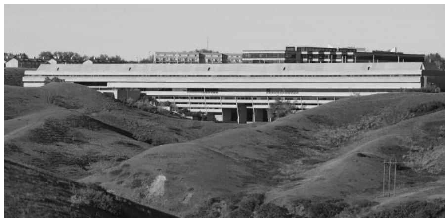
Figura 69 – Relação do edifício e topografia - Universidade de Lethbridge. Fonte: www.uleth.ca
