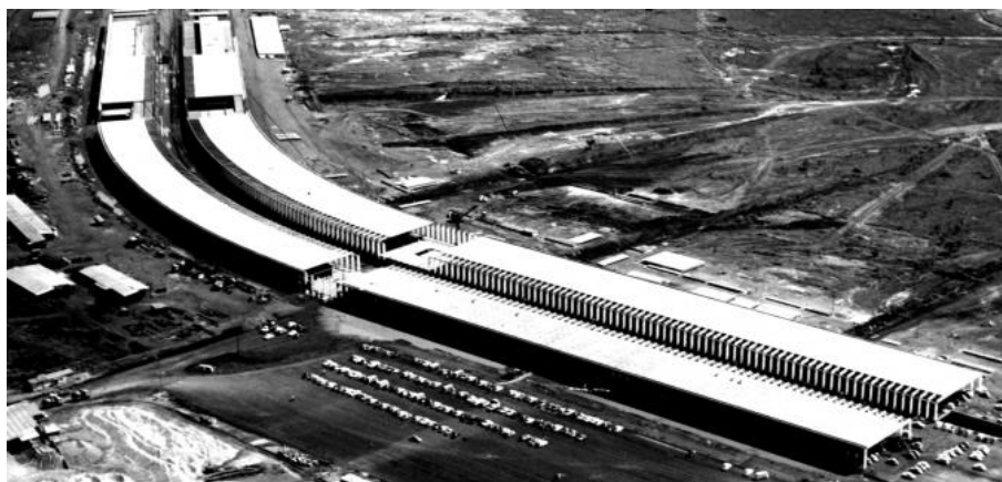
Figura 76 - Edifício ICC. Fonte: www.unb.br/noticias/unbagencia
