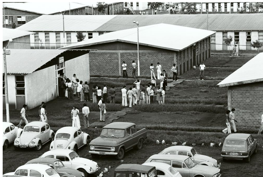
Figura 45 - Blocos Provisórios - sistema pré-fabricado de concreto e chapas de fibrocimento e sistema de alvenaria leve, estrutura de concreto aparente e vedação de alvenaria à vista. Fonte: http://www.sites.uem.br/planodiretor_uem/fotos-campus-sede-uem
