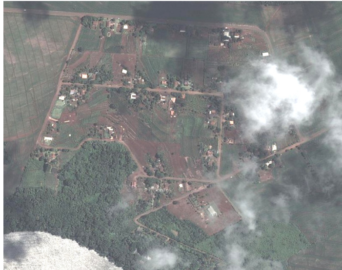
Figura 4.3.2 - Exemplo da tipologia geométrica - Vila Rural Olyntho Shimidt em Ivatuba
