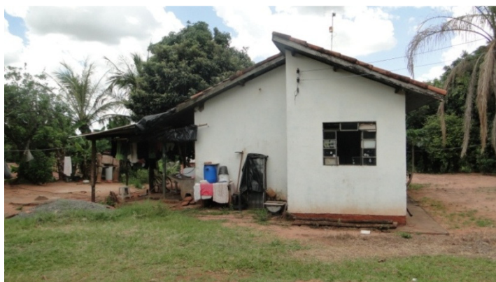
Figura 5.2.1.1.13 - Exemplo de varanda com telha de fibrocimento no sentido transversal
