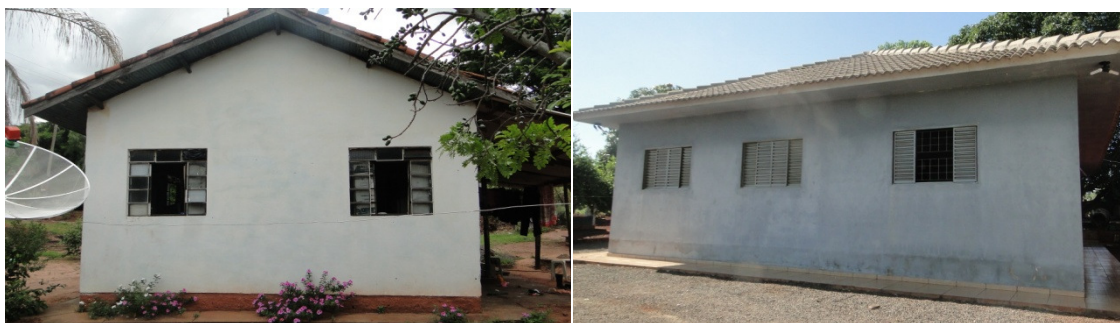
Figuras 5.2.1.1.3 e 5.2.1.1.4 - Troca do telhado, exemplo com o telhado original e com o telhado refeito e aumento do pé-direito
