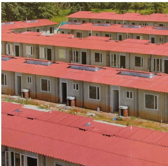
Figura 2.2.1.1 - Habitação rural na Colômbia
