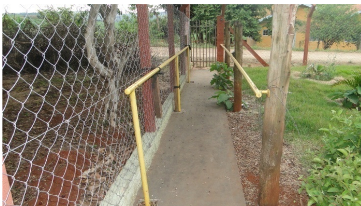
Figura 5.2.1.2.3 - Rampa de acesso à habitação adaptada para o morador portador de necessidades especiais
