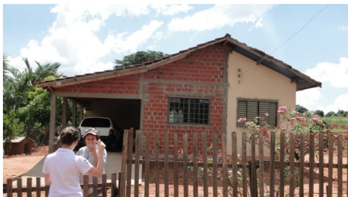
Figura 5.2.1.1.12 - Exemplo de ampliação com telha de cerâmica no sentido transversal
