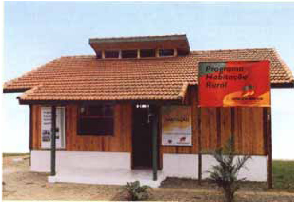
Figura 2.3.1.2 - Protótipo construído da habitação
