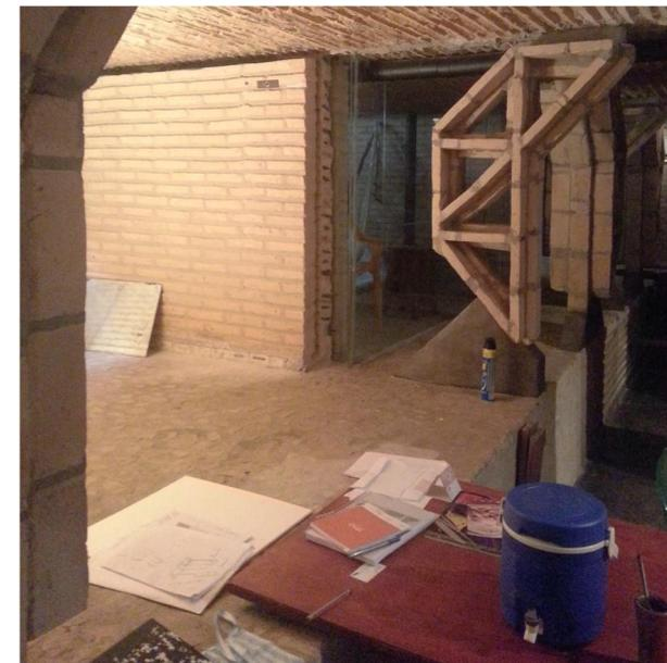
Figura 57: Intervenção no subsolo: pilares treliçados.
