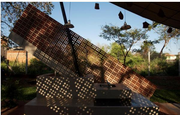
Figura 137: Fechamento lateral em tijolos de 6 furos.
