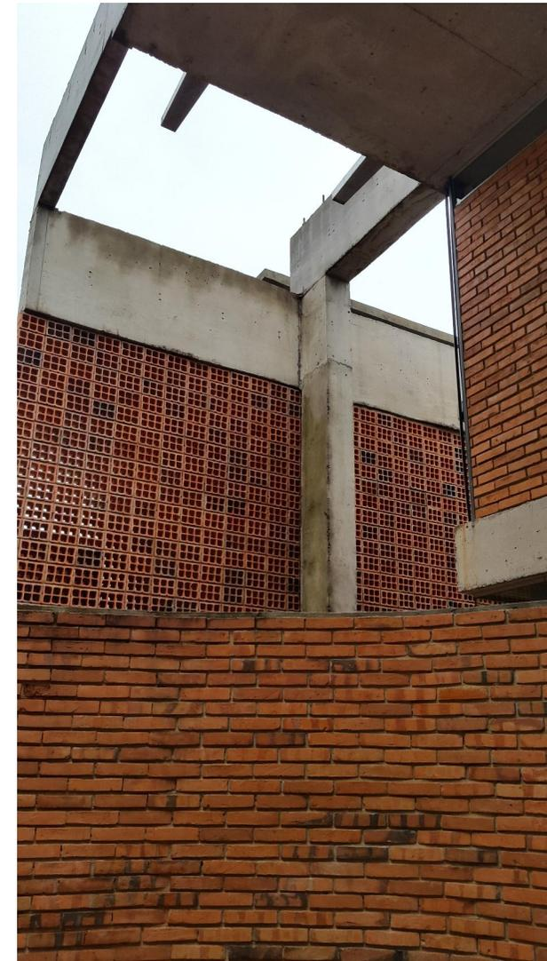
Figura 152: Paredes de elementos vazados.
