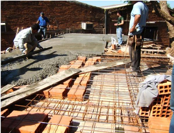
Figura 90: Concretagem da laje-piso.
