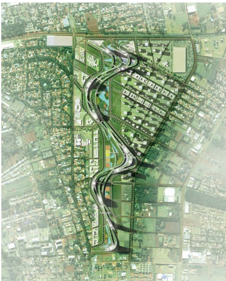
Figura 35 Vista geral do empreendimento Eurogarden
