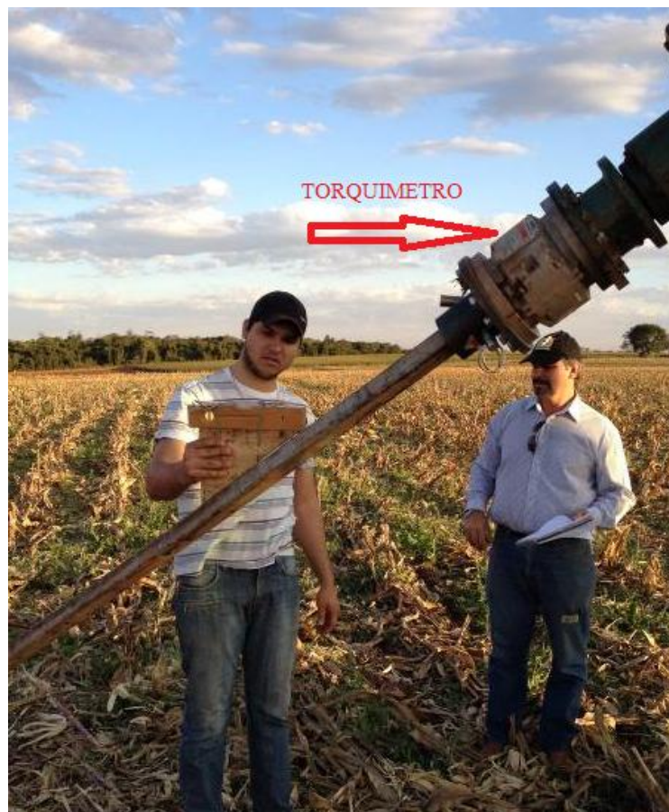
Figura 24 – Procedimento de instalação da estaca helicoidal
