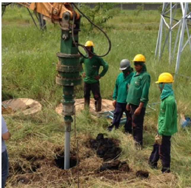
Figura 9 - Motor hidráulico para instalação da estaca
