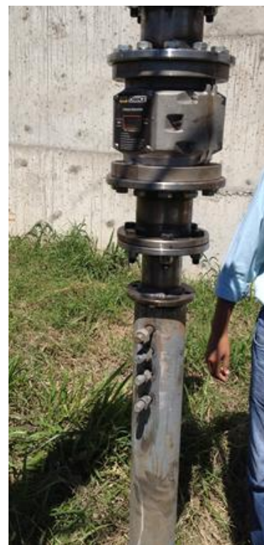
Figura 2 - Esquema de instalação de estacas helicoidais multi-hélices
