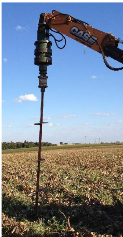
Figura 2 - Esquema de instalação de estacas helicoidais multi-hélices
