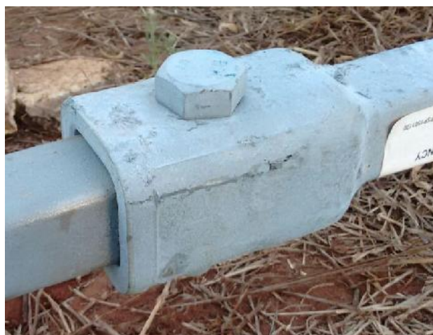
Figura 10 - Emenda das estacas com eixo maciço
