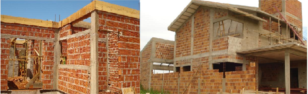
**Figura 2 - Sistema em alvenaria convencional**
