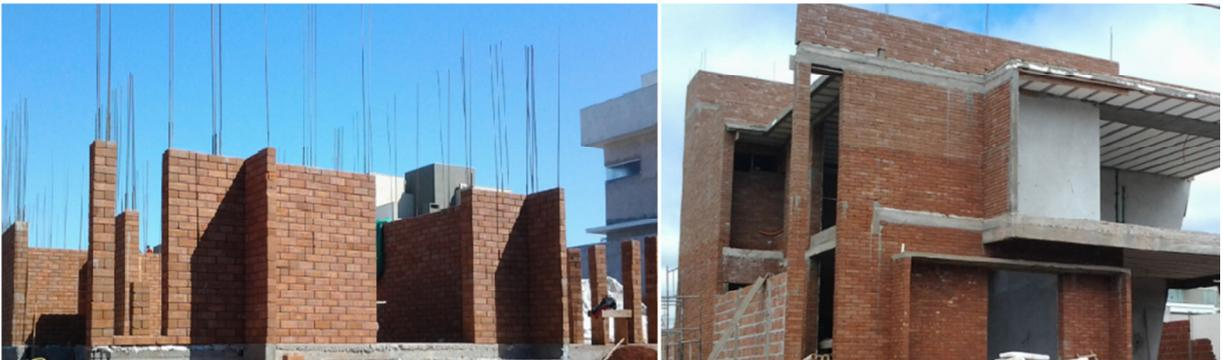
**Figura 3 - Sistema em alvenaria com tijolos de solo-cimento**
