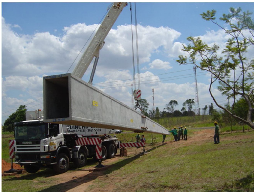
Figura 2.3: Poste com seção retangular vazada sendo içado por guincho
