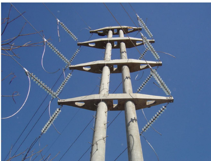
Figura 2.4: Estrutura em ângulo
